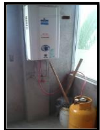
Figura 12c. Nodo Sensor 1 en bodega.
