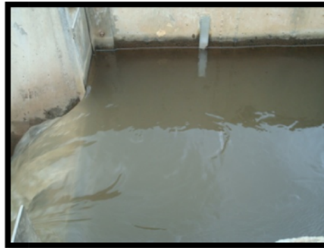
Fig. 4c. Regla ubicada en el vertedero
