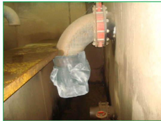
Fig. 69b. Ubicación de la canastilla en la válvula de descarga del agua de lavado.
