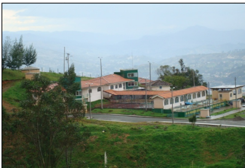
Fig. 1. Planta de Tratamiento de Agua Potable "Mahuarcay"
