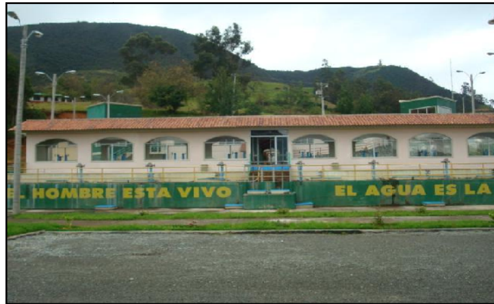
Fig. 2. Planta de Tratamiento de Agua Potable "Mahuarcay"
