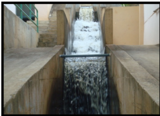
Fig. 5a Resalto hidráulico
