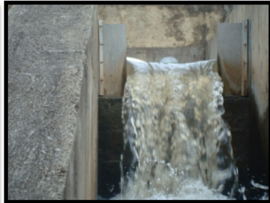
Fig. 4b Vertedero rectangular
