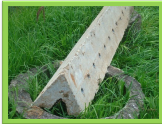
Fig. 26a. Vigueta prefabricada de concreto
