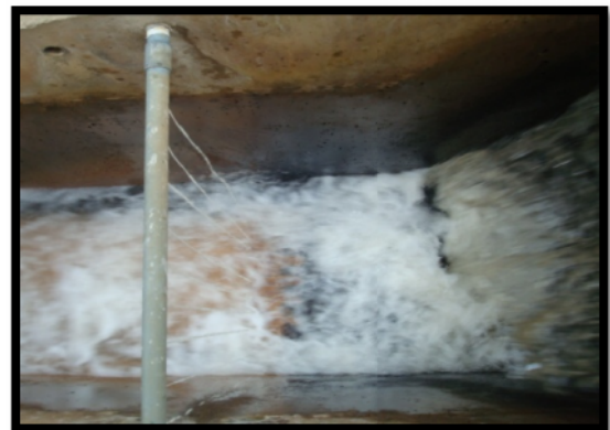
Fig. 5b Flauta para dosificar sulfato de aluminio
