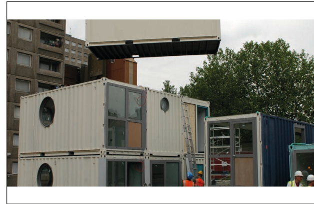
Imagen 45: Etapa de construcción de Centro FAWOOD
