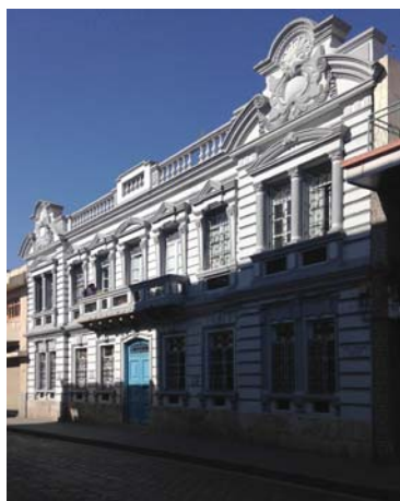
Fig. 61: Fachada Colegio San Francisco.
