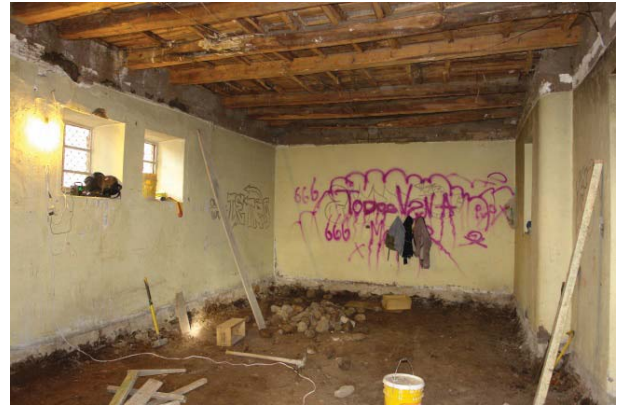
Fig. 95. Fotografía de uno de los espacios en el que se aprecia los componentes del entresiso.
