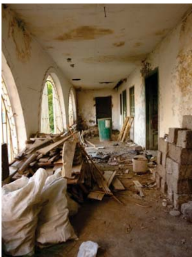
Fig. 91. Fotografía del área de corredor cubierto con los respectivos ingresos a los diferentes ambientes.
