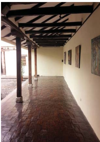
Fig. 6: Pasillo interior. Casa de las Posadas. Cuenca.
