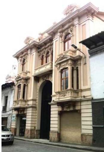
Fig. 59: Fachada Pasaje León.
