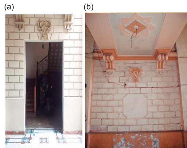
Fig. 125. Grada principal en ala este (a). Pared existente que reemplaza al espacio de grada principal en ala oeste (b). Año 2005.
