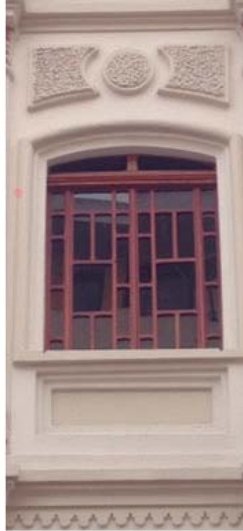
Fig. 160. Detalle de antepecho, dintel y ventana de planta alta.
