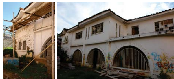
Fig. 92. Fotografías de elevación oeste en las que se observa claramente la diferencia en textura entre el adobe y el ladrillo.
