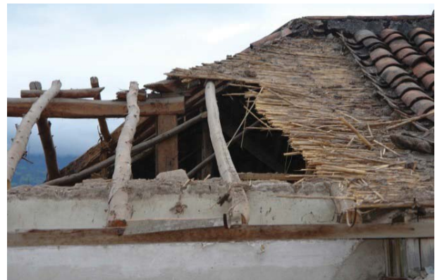
Fig. 97. Fotografía de componentes de cubierta.
