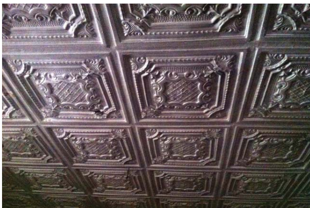
Fig. 100. Fotografía de cielo raso compuesto por estucos de yeso en bajo relieve.
