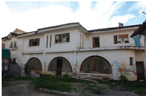
Fig. 101. Fotografía de elevación oeste.
