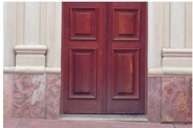
Fig. 157. Detalle de zócalo.
