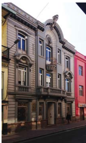
Fig. 62: Fachada Edificio Banco Internacional.
