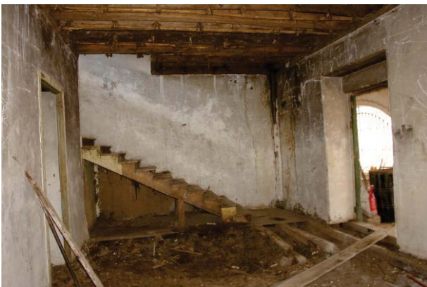
Fig. 90. Fotografía del área del área de sala con grada al fondo.
