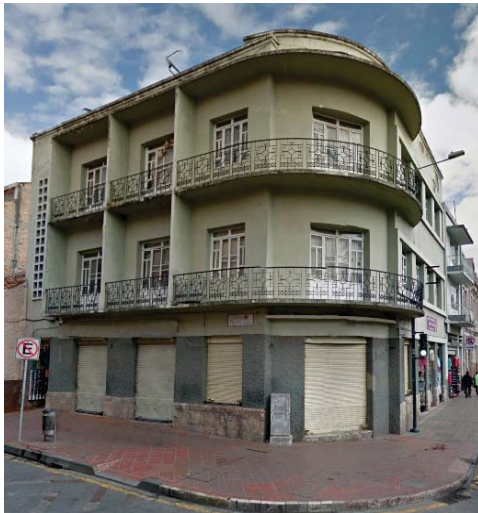
Fig. 68: Fachada Casa Alberto Esquivel.
