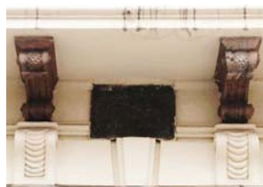
Fig. 58.3: Detalle Placa y Ménsulas
