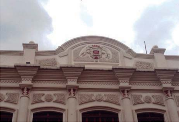
Fig. 162. Detalle de cornisa compuesta por molduras fileteadas.
