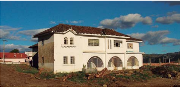
Fig. 78. Fachada oeste de la Casa Quinta Lupercio.
