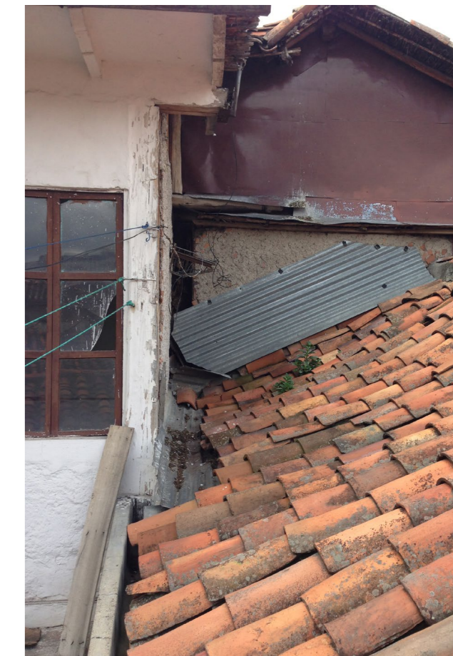
FIG. 5 Equipo de trabajo, 2016. Terraza del estado previo del restaurante Laktana, Cuenca
