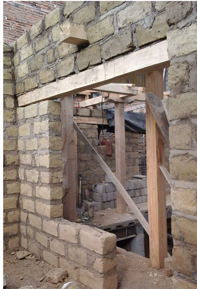
FIG. 3 Equipo de trabajo, 2016. Intervención arquitectónica en un bien patrimonial, Cuenca
