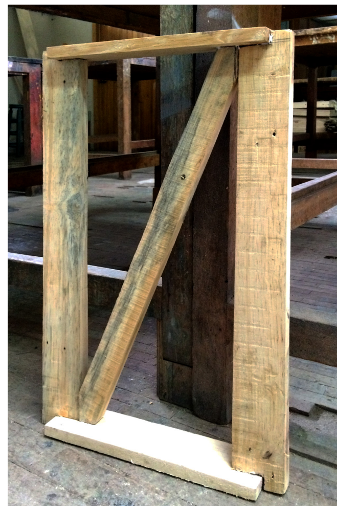
i.362 Gárate, L & Morales, J. (2016) Armado panel T7 [Fotografía]. Cuenca, Ecuador.
