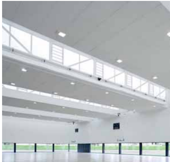
Foto 3.25. Estructura de cubierta sobre cancha multiuso. Fuente: (BCQ arquitectura, 2015)
