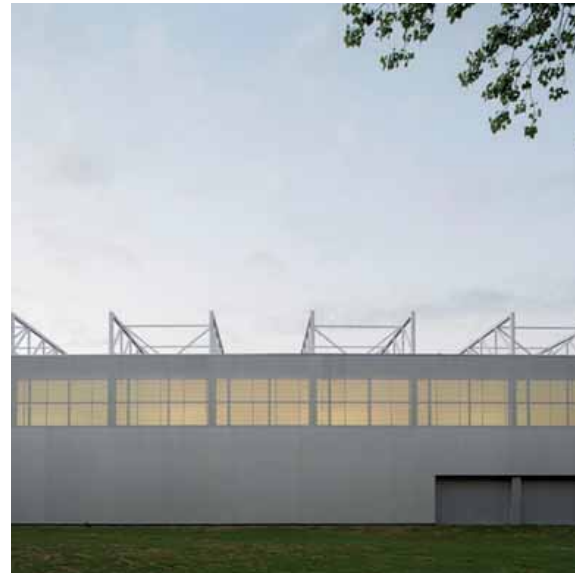
Foto 3.28. Fachada del segundo volumen del pabellón. Fuente: (BCQ arquitectura, 2015)
