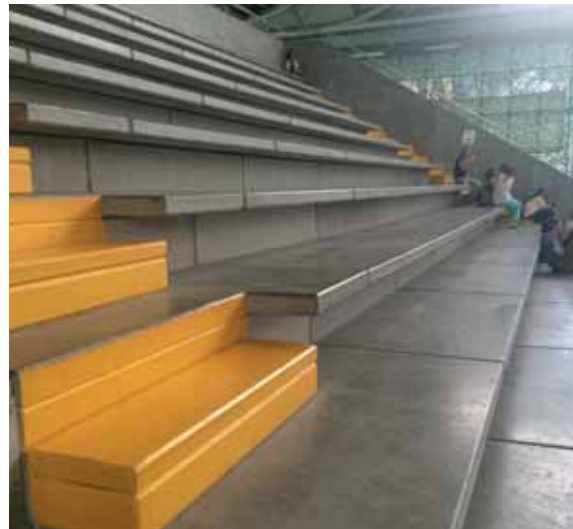
Foto 3.5. Graderios de coliseos hormigón prefabricado.
