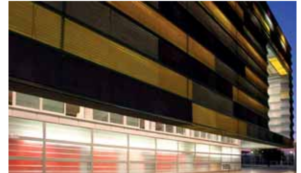
Foto 3.15. Recubrimiento de poliéster coloreado y ventanas del polideportivo.
