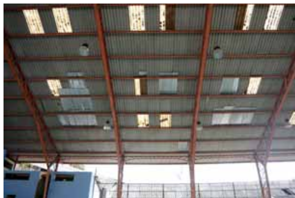
Foto 2.4. Cubierta y cerchas metálicas. Fuente: Grupo de tesis.
