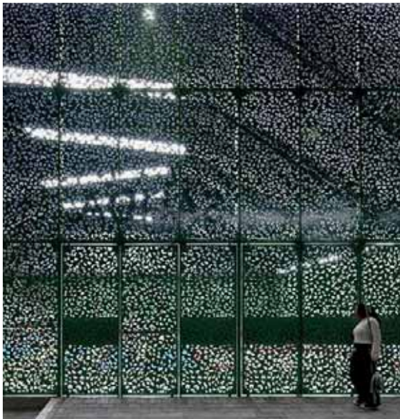
Foto 3.4. Fachada de acero perforada de coliseo de gimnasia.
