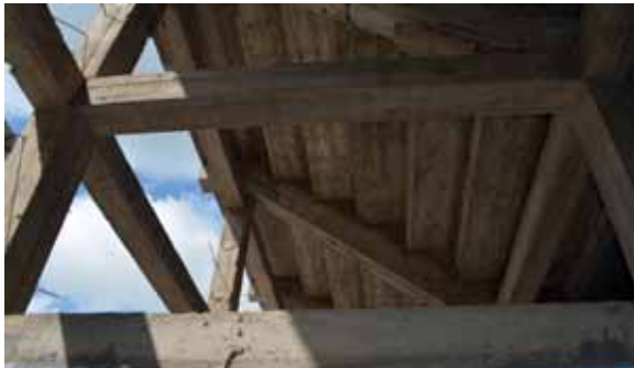
Foto 2.13. Estructura de hormigón armado para graderíos. Fuente: Grupo de tesis.
