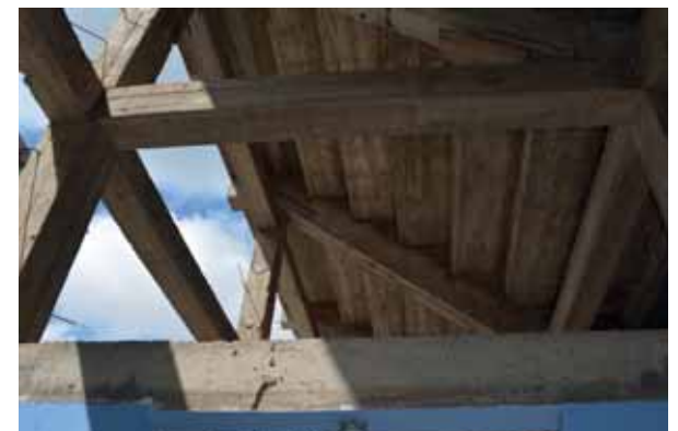
Foto 2.5. Estructura de graderios del coliseo. Fuente: Grupo de tesis.
