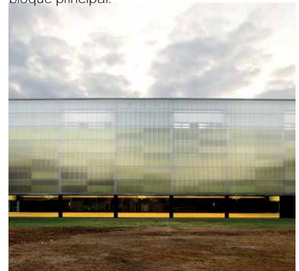
Foto 3.26. Fachada del bloque principal. Fuente: (BCQ arquitectura, 2015)
