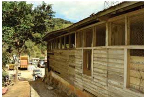
Foto 1.23. Antigua fábrica de químicos Fuente: Grupo de tesis
