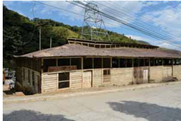
Foto 1.22. Antigua fábrica de químicos Fuente: Grupo de tesis.
