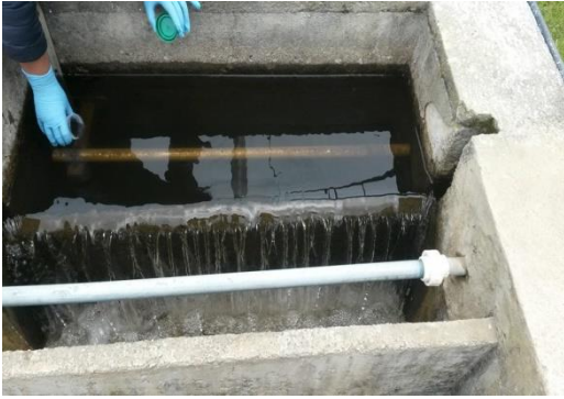
Imagen 9: Toma de muestra de agua cruda
