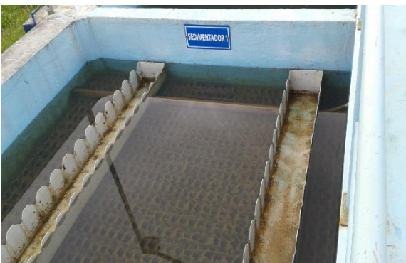
Imagen 6: sedimentador
