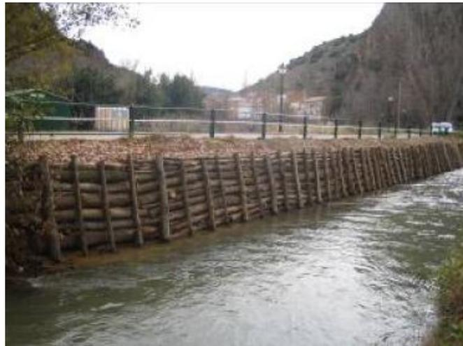
Figura 7. Empalizada construida. (Fuente: Tragsa, 2007)
