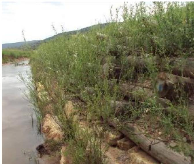
*Figura 6. Muro krainer construido y revegetado.
