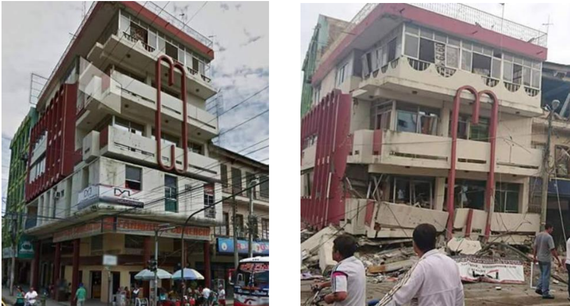
Figura 30: Edificio antes y después del sismo del 16 de abril del 2016 en Ecuador. Se observa que la edificación no cumplía el criterio de columna fuerte viga-débil formándose de un piso blando.
