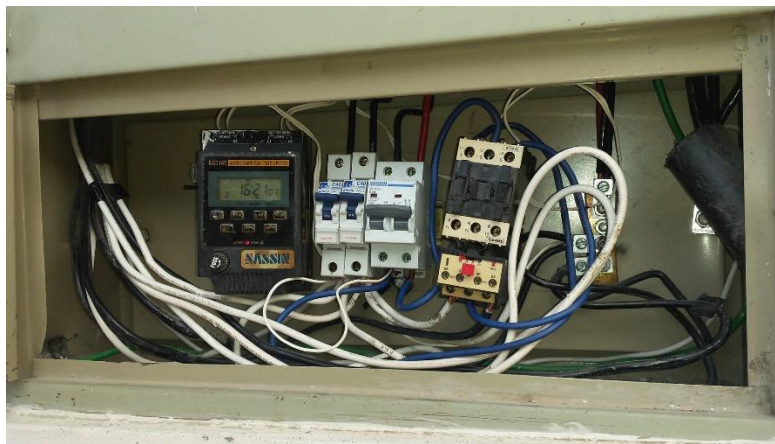
Figura 4.14 Imagen de la colocación del temporizador
