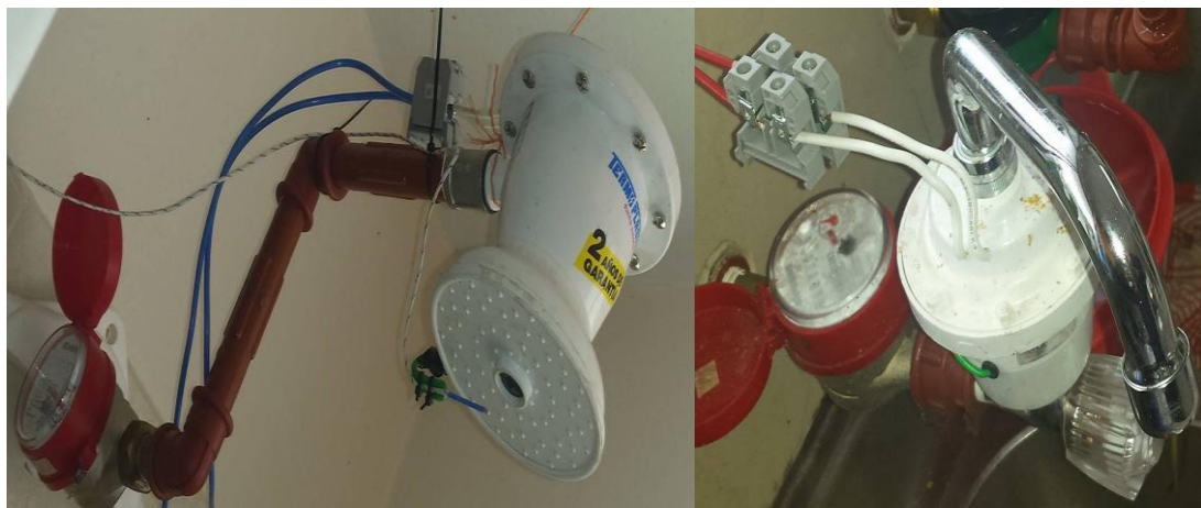
Figura 3.10 Fotografía de la instalación de la ducha eléctrica
