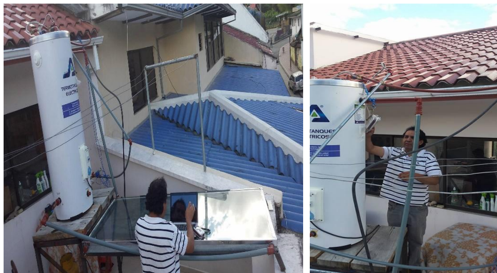
Figura 4.18 Imágenes de la instalación del sistema solar eléctrico modificado
