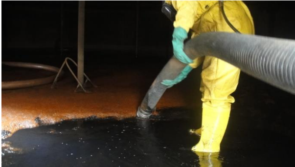
Imagen 5: Extracción de lodos con moto – bomba.
