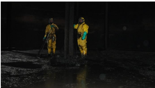
Imagen 3: Limpieza de superficie de tanque.
