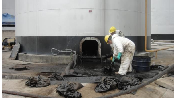
Imagen 6: Evacuación de lodos en el exterior.
