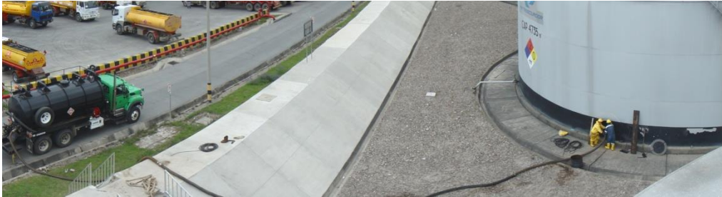
Imagen 12: Extracción de lodos con moto – bomba.
