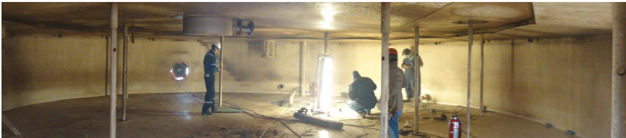
Imagen 7: Trabajos de mantenimiento, cambio de tubería.
