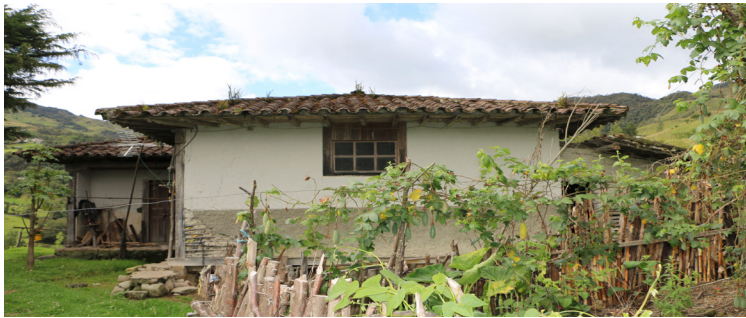
Fotografía 62. Fachada lateral sur. Fuente: Grupo de tesis, 2016.
