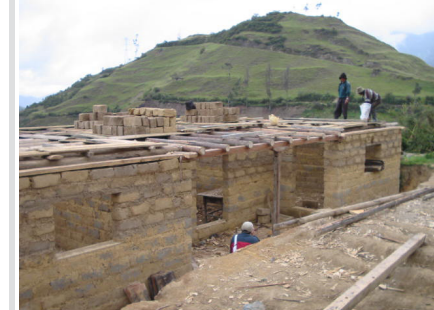
Fotografía 17: Proceso de construcción de una vivienda tradicional del pueblo Saraguro. Fuente: http://jeamilburneo.blogspot.com/2007/11/proyecto-etnocultural-en-ciudadela-loja.html , 2007.
