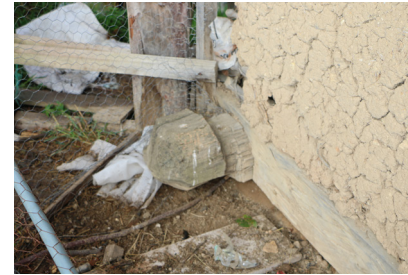
Fotografía 50. Vigas de madera. Fuente: Grupo de tesis, 2016.
