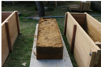
Fotografía 19.- Muro de tapial desencofrado. Fuente: Grupo de Tesis, 2015.
