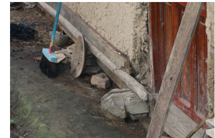
Fotografía 54. Cimentación. Fuente: Grupo de tesis, 2016.
