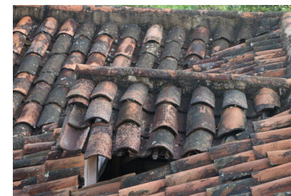
Fotografía 56. Cubierta. Fuente: Grupo de tesis, 2016.
