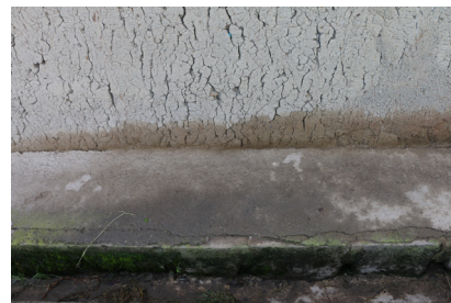
Fotografía 38. Cimentación. Fuente: Grupo de tesis, 2016.
