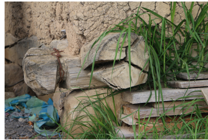
Fotografía 49. Cimientos. Fuente: Grupo de tesis, 2016.
