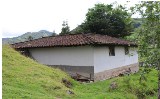
Fotografía 63. Fachada lateral norte. Fuente: Grupo de tesis, 2016.
