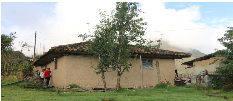
Fotografía 47. Fachada lateral sur Fuente: Grupo de tesis, 2016.
