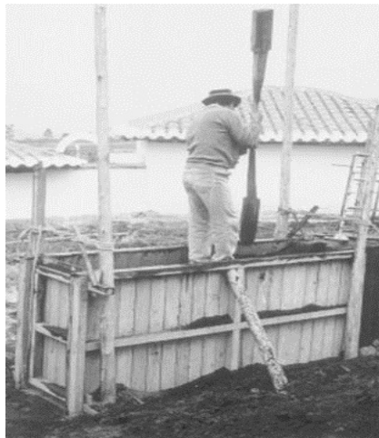
Fotografía 20: Fabricación de muro de tapial desencofrado. Fuente: Minke 2001
