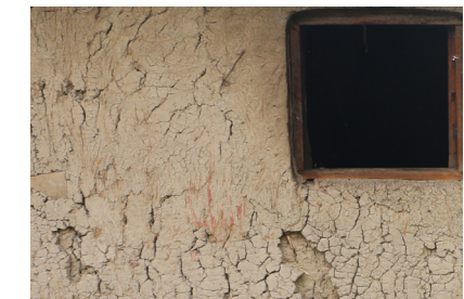
Fotografía 40. Revoque. Fuente: Grupo de tesis, 2016.
