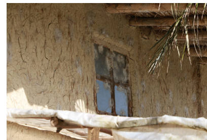
Fotografía 39. Ventana. Fuente: Grupo de tesis, 2016.
