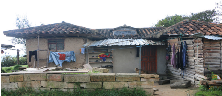
Fotografía 45. Fachada frontal. Fuente: Grupo de tesis, 2016.
