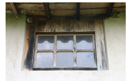
Fotografía 74. Ventana. Fuente: Grupo de tesis, 2016.
