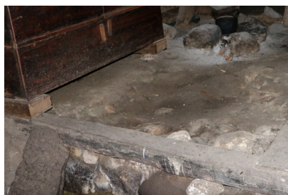
Fotografía 73. Piso cocina. Fuente: Grupo de tesis, 2016.
