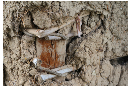
Fotografía 52. Pilar esquinas. Fuente: Grupo de tesis, 2016.
