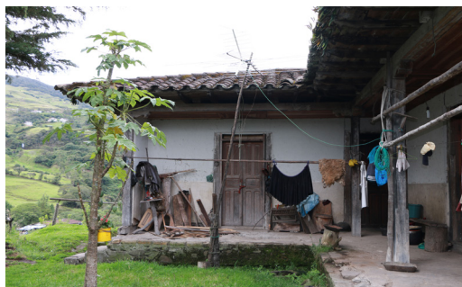
Fotografía 65. Fachada lateral sur. Fuente: Grupo de tesis, 2016.
