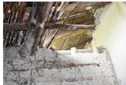
Fotografía 69. Pared y cubierta. Fuente: Grupo de tesis, 2016.
