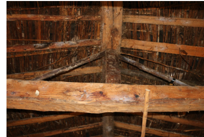
Fotografía 33. Cubierta. Fuente: Grupo de tesis, 2016.
