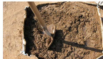
Imagen 38. Dosificación de la tierra Fuente: http://internundos.org/casa_ecologica/wp-content/uploads/2009/06/panete.jpg
