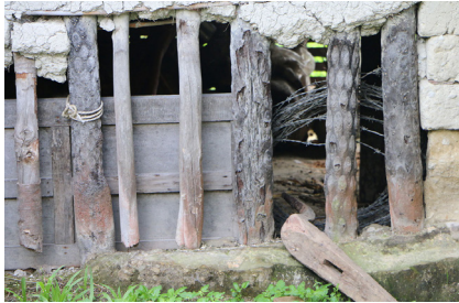
Fotografía 11. Sistema constructivo bahareque parado. Fuente: Grupo de Tesis, 2016.
