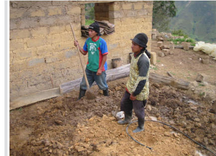
Fotografía 16: Proceso de construcción de una vivienda tradicional del pueblo Saraguro. Fuente: http://jeamilburneo.blogspot.com/2007/11/proyecto-etnocultural-en-ciudadela-loja.html , 2007.
