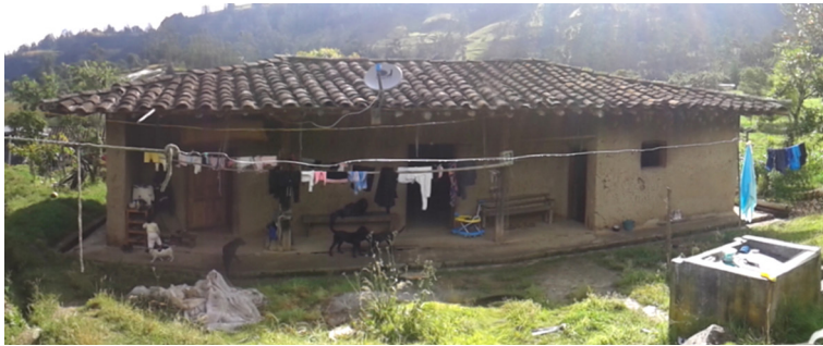
Fotografía 26. Fachada Oeste. Fuente: Grupo de tesis, 2016.
