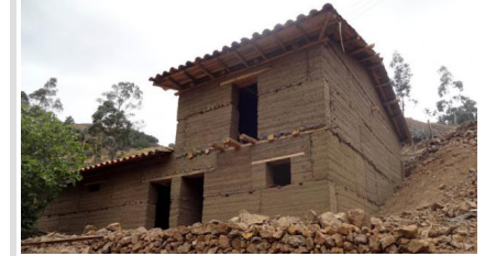
Fotografía 21: Casa de tapial, Gualaquí - Loja Fuente: http://www.elcomercio.com/tendencias/construir/construccion-loja-zonasrurales-tapial-edificaciones.html , 2013.
