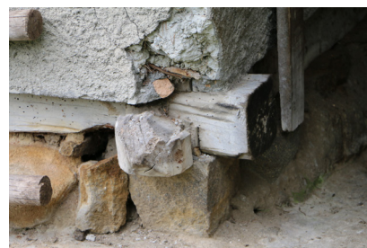
Fotografía 72. Cimientos posteriores. Fuente: Grupo de tesis, 2016.
