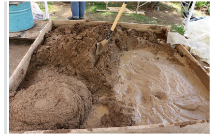
Fotografía 10: Preparación de la tierra para ser usada en los sistemas constructivos tradicionales Fuente: Grupo de tesis, 2016.
