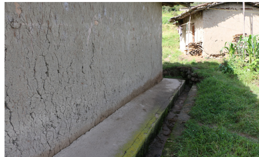
Fotografía 29. Cimentación Fuente: Grupo de tesis, 2016.
