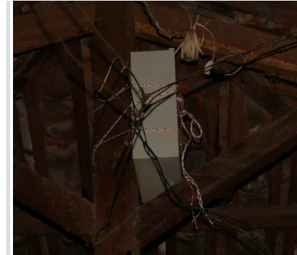
Fotografía 24: Montaje del equipo. Fuente: Grupo de tesis, 2016.
