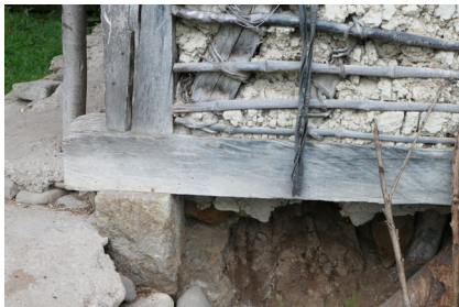
Fotografía 12. Sistema constructivo bahareque galluchaqui. Fuente: Grupo de Tesis, 2016.
