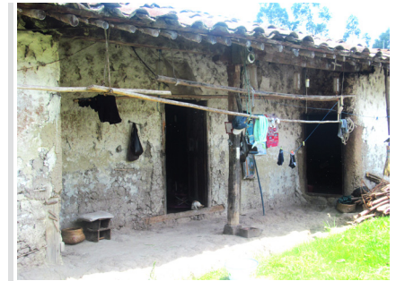
Fotografía 13. Vivienda tradicional con el sistema constructivo bahareque. Fuente: Chalan L, 2015.
