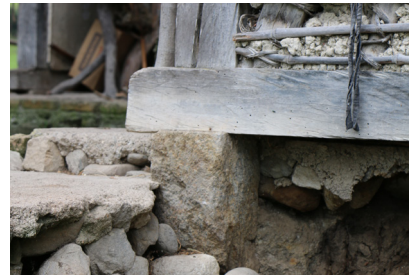
Fotografía 66. Cimientos. Fuente: Grupo de tesis, 2016.
