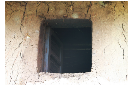
Fotografía 36. Ventana. Fuente: Grupo de tesis, 2016.
