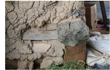
Fotografía 51. Plintos. Fuente: Grupo de tesis, 2016.
