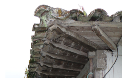
Fotografía 71. Cubierta. Fuente: Grupo de tesis, 2016.
