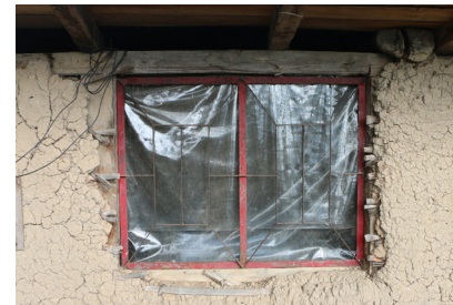
Fotografía 53. Ventana. Fuente: Grupo de tesis, 2016.
