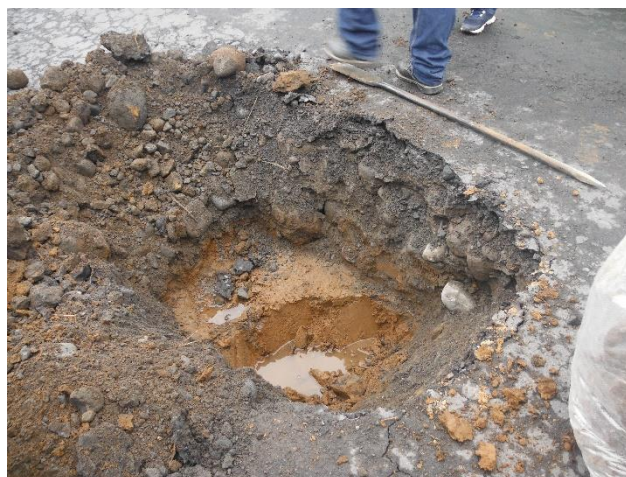
Fotografía 3.4 Perforación a cielo abierto calicata 2, vía Troncal Amazónica - Mutinsa.
