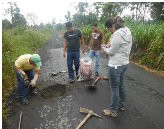
Fotografía 3.1 Proceso de obtención de la muestra a cielo abierto en la vía Troncal Amazónica - Mutinsa.
