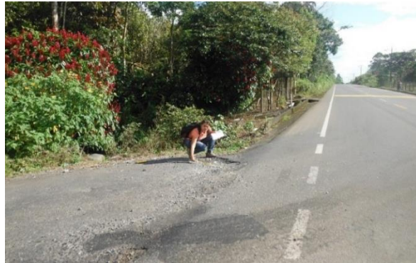
Fotografía 3.18 Medición de estado de cruces vía Troncal Amazónica - Mutinsa.
