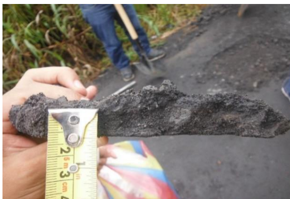
Fotografía 3.15 Espesor de imprimación reforzada de la vía Troncal Amazónica - Mutinsa.
