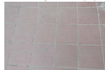
Img. 43. Desprendimiento de cerámicas.
