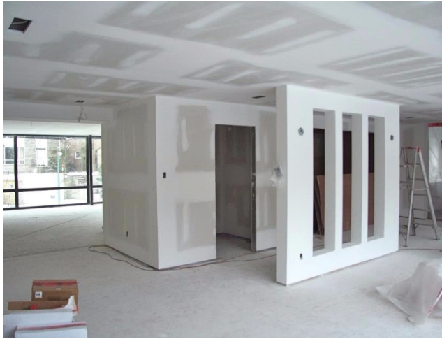
Imagen 07 Limpieza de un sistema constructivo en seco
