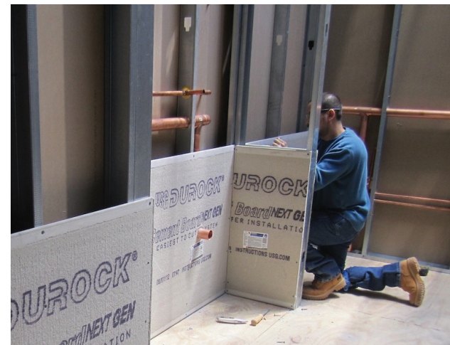
Imagen 01 Sistema constructivo seco
