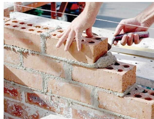
Imagen 02 Sistema constructivo húmedo
