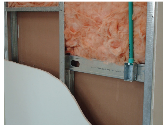
Imagen 05 Instalaciones de un sistema constructivo en seco
