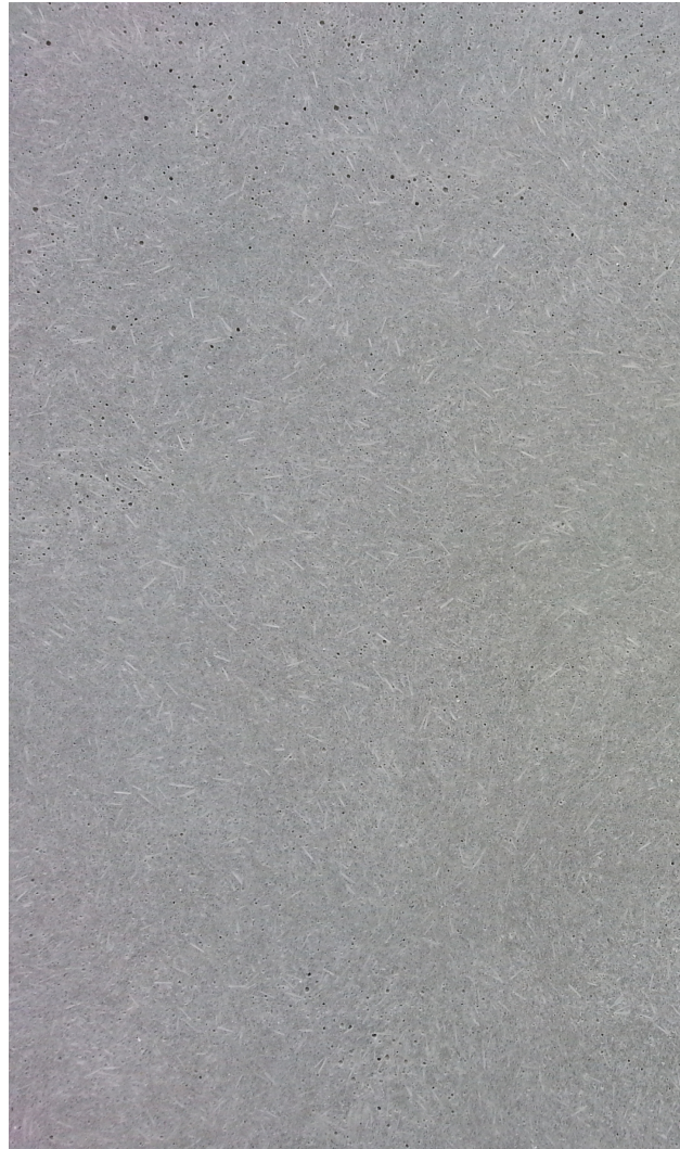
Imagen 05 Pulido con discos de concreto
