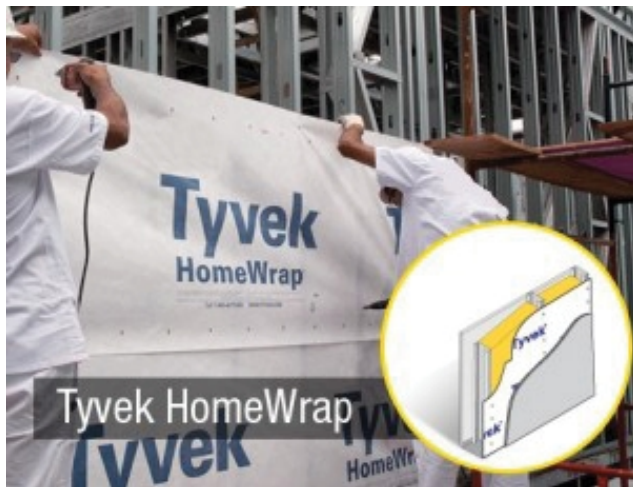
Imagen 40 Colocación de la Membrana Hidrofuga DuPont™ Tyvek®
