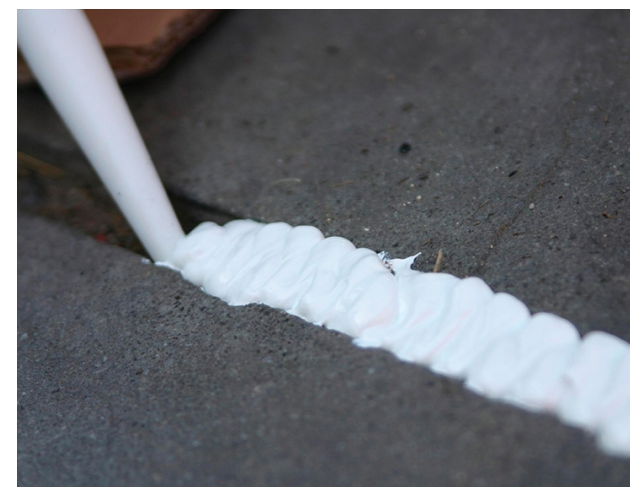
Imagen 45 Colocación del sellador de poliuretano
