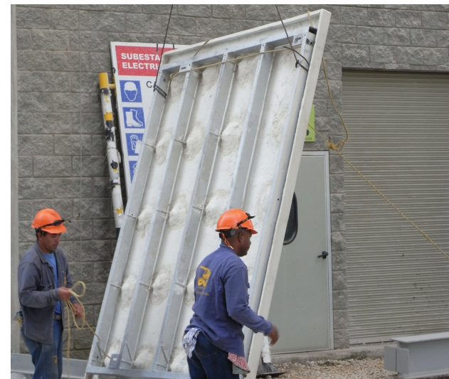
Imagen 31 Panel de Micro - hormigón reforzado con fibra de vidrio alcalinoresistente
