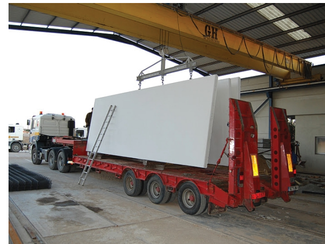
Imagen 44 Dimensión de un panel en función de la capacidad de transporte
