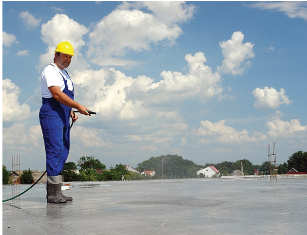
Imagen 41 Curado del hormigón
