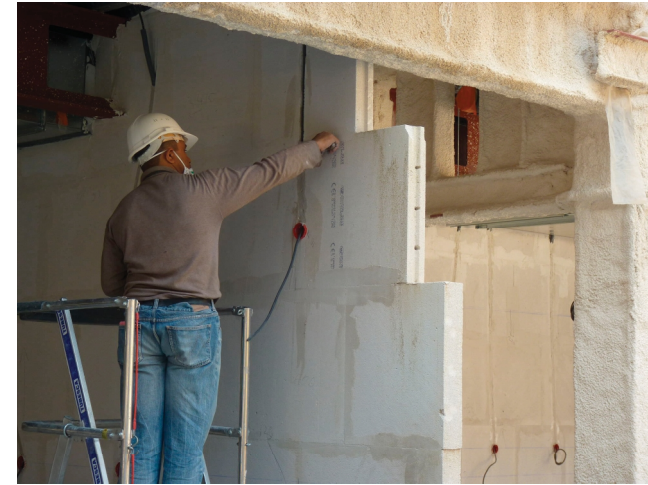
Imagen 28 Paneles ligeros de hormigón prefabricado
