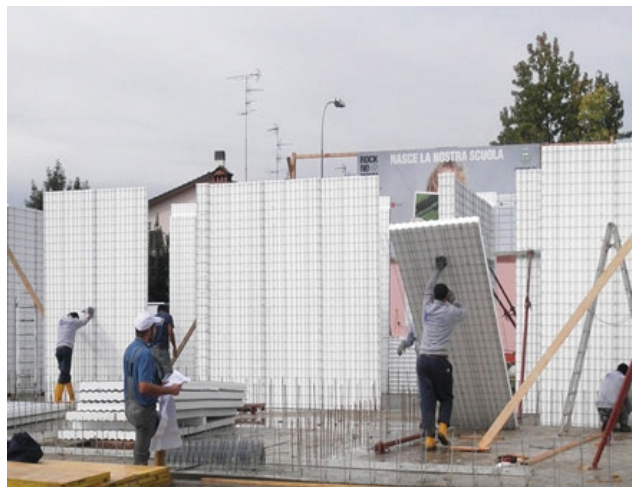
Imagen 60 Vivienda realizada con el sistema constructivo Hormi2
