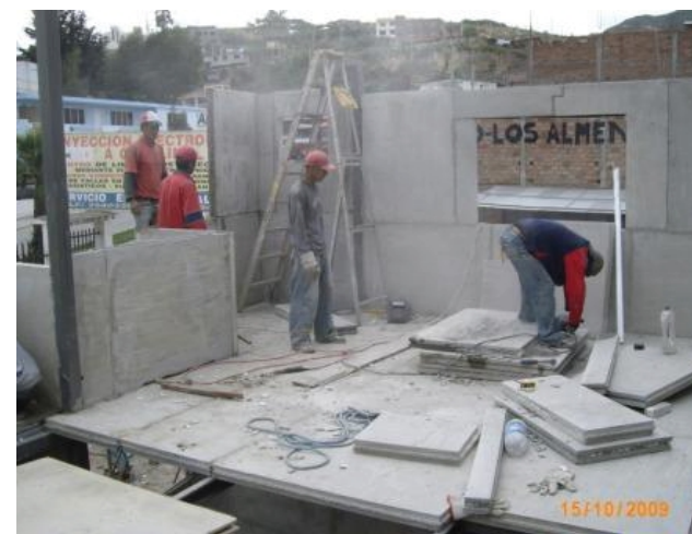
Imagen 57 Instalación paneles Hormypol
