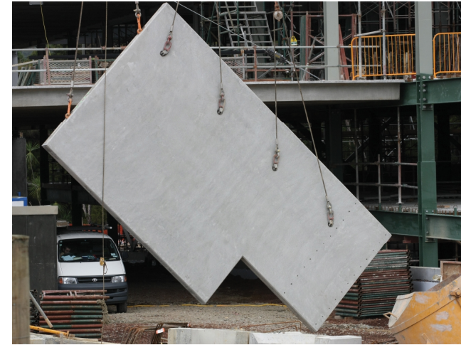
Imagen 43 Montaje de paneles hormigón prefabricado arquitectónico
