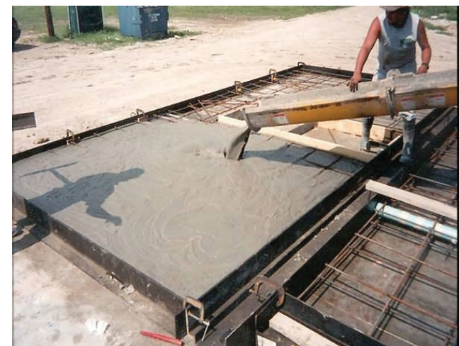
Imagen 40 Vertido del hormigón en el molde
