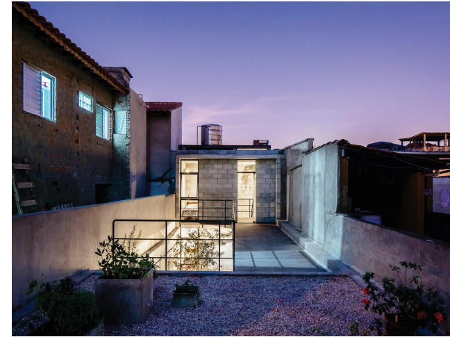
Imagen 01 Cerramientos Horizontales: Cubierta
