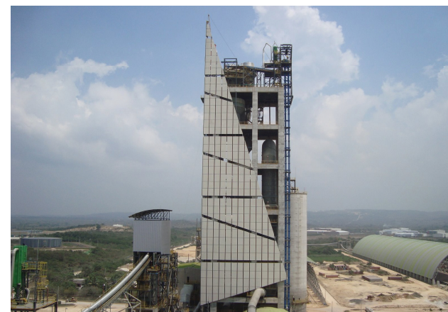
Imagen 32 Fachada de hormigón arquitectónico compuesto por paneles de Micro - hormigón reforzado con fibra de vidrio alcalinoresistente
