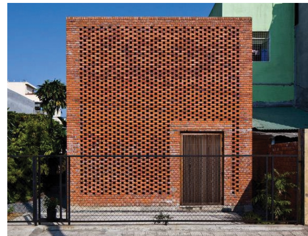
Imagen 20 Fachada in situ
