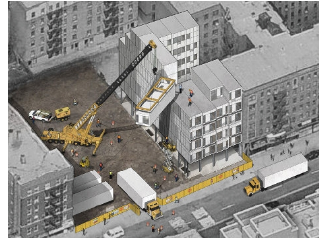
Imagen 23 Colocación de elementos prefabricados
