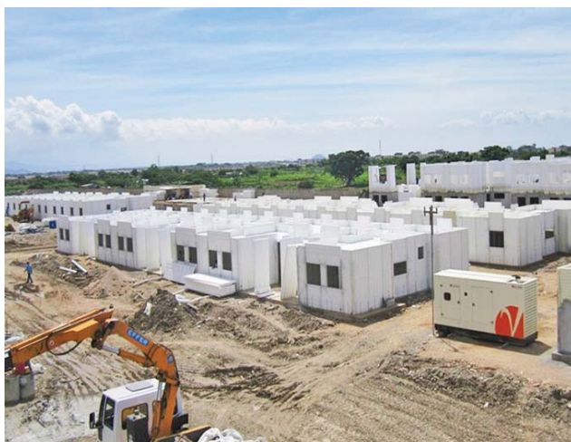
Imagen 55 Viviendas realizadas con el sistema constructivo Construpanel®
