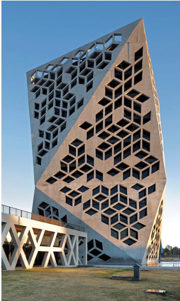
Imagen 30 Edificio compuesto por paneles de hormigón prefabricado arquitectónico: Centro Cívico Bicentenario / Lucio Morini + GGMPU Arquitectos
