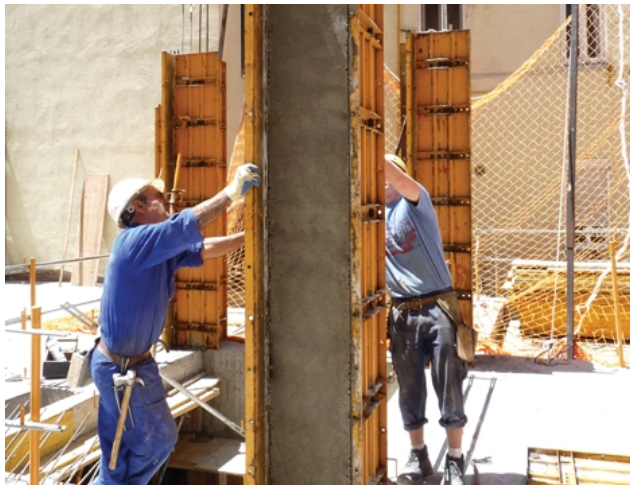
Imagen 42 Desencofrado del hormigón
