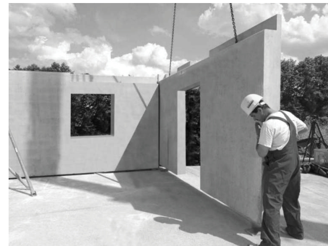
Imagen 29 Paneles pesados de hormigón prefabricado
