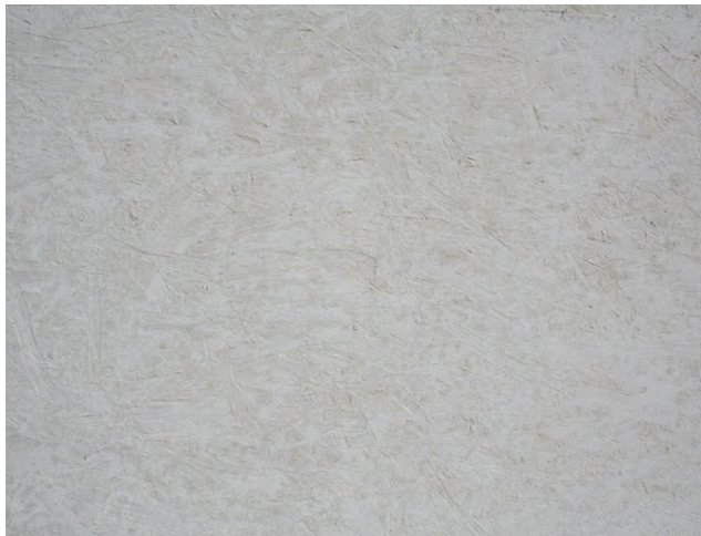
Imagen 34 Textura del hormigón
