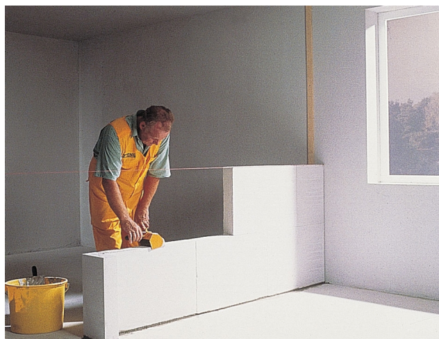
Imagen 04 Colocación de tabiques interiores
