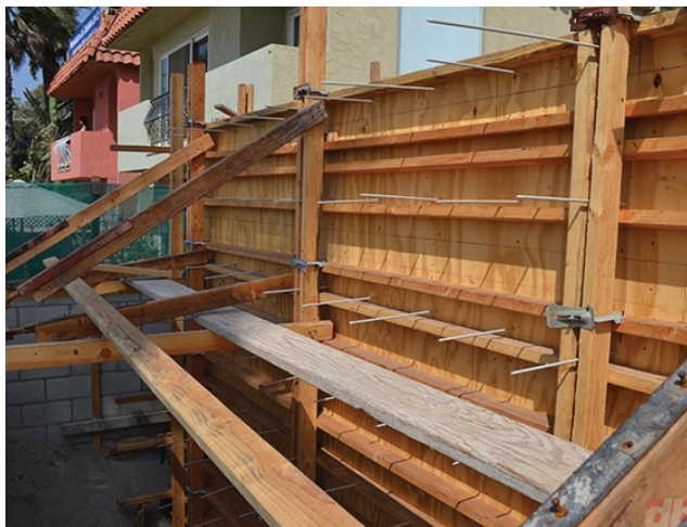
Imagen 38 Encofrado de madera
