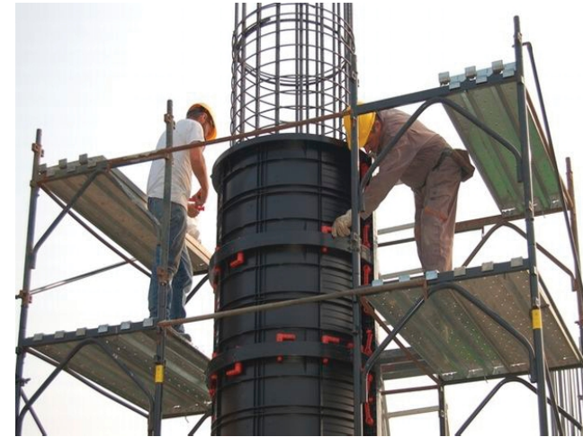
Imagen 39 Encofrado de plástico
