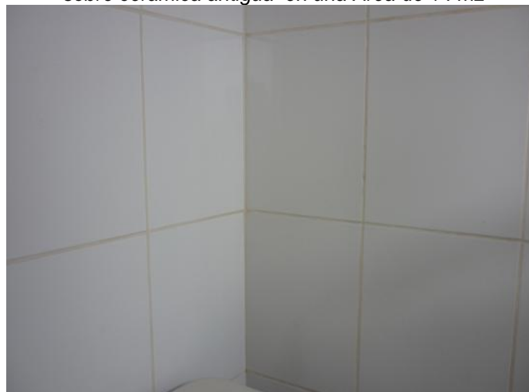
Figura 21 Uso del Pegante Plus en Pared ; Cerámica 25 x 33 cm sobre cerámica antigua en una Área de 14 m 2
