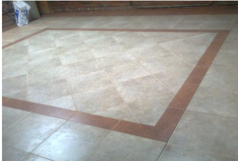
Figura 22 Uso del Pegante Plus en Piso; Cerámica 42.5 x 42.5 cm sobre cerámica antigua en una Área de 30 m 2
