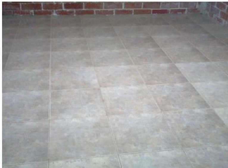
Figura 19 Uso del Pegante Standard ; Cerámica 42.5 x 42.5 cm sobre piso de concreto en una Área de 16 m 2
