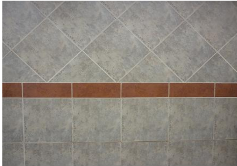
Figura 18 Uso del Pegante Pegatex Standard ; Cerámica 42.5 x 42.5 cm sobre pared de concreto en una Área de 30m 2
