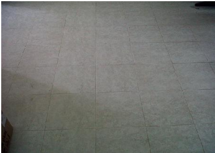
Figura 23 Uso del Pegante Porcelanato en Piso; Porcelanato 42.5 x 42.5 cm sobre cerámica antigua en una Área de 60 m 2
