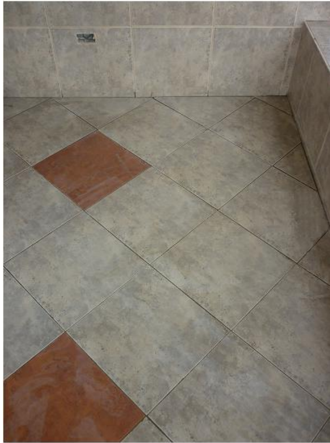
Figura 20 Uso del Pegante Pegatex Standard ; Cerámica 42.5 x 42.5 cm Piso y pared de concreto en una Área de 60m 2
