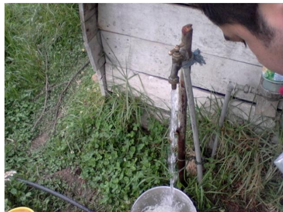
Ilustración 33: Corrida de agua.
