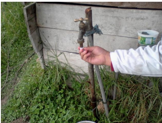
Ilustración 32: Sanitización de llave de agua.
