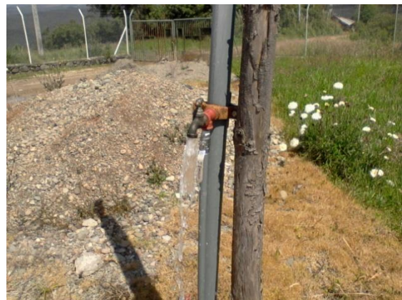
Ilustración 23: Corrida de agua.
