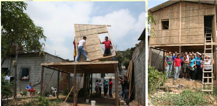
Figura: 24.- Imagen del “Proceso de armado de viviendas Hogar de Cristo”
