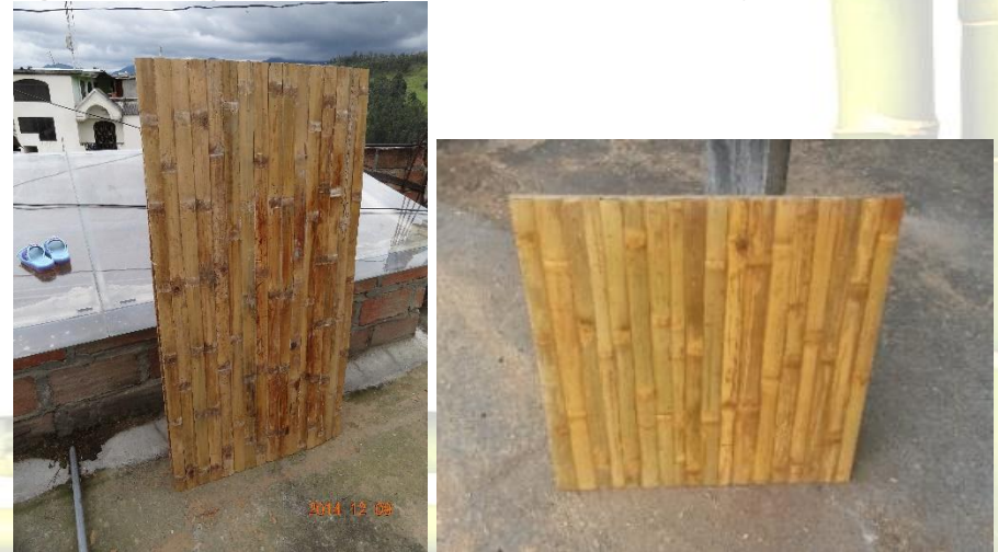
Figura: 57.- Imagen: Prensado de las latillas, tablero de 1.2m y 0.60m.
