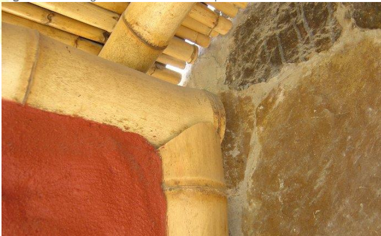
Figura: 37.- Imagen de "Corte Boca de pescado"
