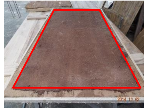
Figura: 70.- Imagen: Capa de mezcla aserrín + cola 1cm
