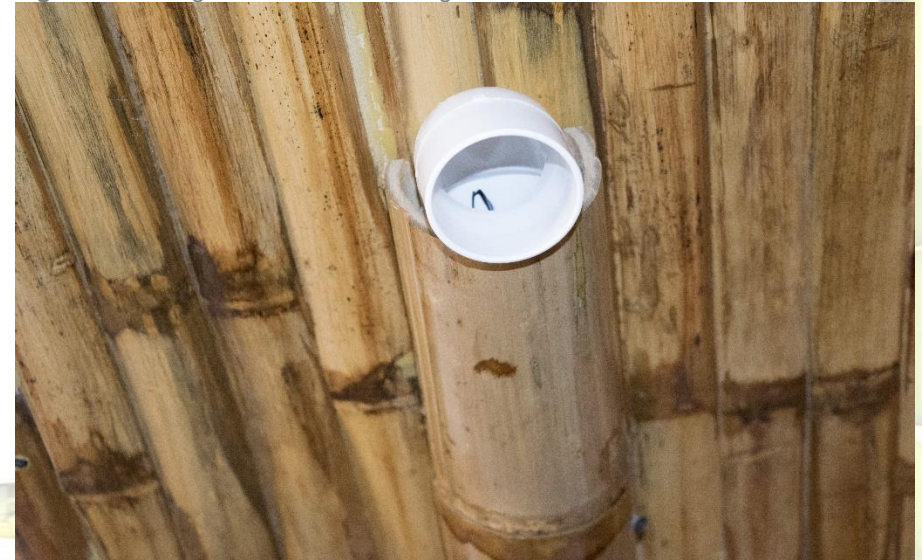
Figura: 78.- Imagen: Instalaciones de aguas servidas.
