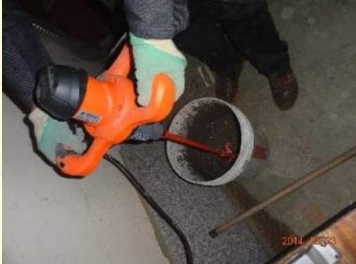
Figura: 61.- Imagen: Mezcla de los componentes empleados, con mezcladora.
