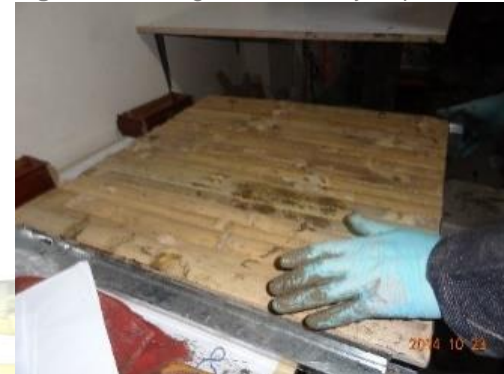
Figura: 64.- Imagen: Colocada y limpieza de la tapa.
