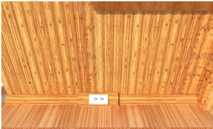
DETALLE DE INSTALACIONES ELÉCTRICAS II
