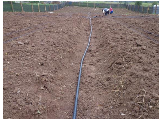
Instalación del sistema de riego Zhañay, W.A. (Noviembre, 2014)
