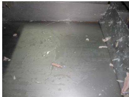
Plataforma de la picadora antes de la limpieza
