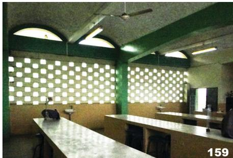
(mampostería trabada y retranqueada); muros abiertos permeables (mampostería trabada, retranqueada y desfasada); muros cerrados permeables (mampostería trabada, retranqueada, y cerrada con bloque de vidrio traslucido); ventanales con celosías bajas y altas y espacios vacíos para circulación de aire; cubiertas con aislamiento térmico (bovedillas de ladrillo y hormigón) y tímpanos vacíos para circulación cruzada del viento.
