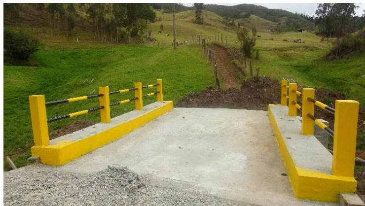
Foto 8 Puente sobre el río Chapar Terminado.
