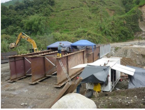
Foto 66 Armado de vigas con ayuda del pórtico estructural Puente el Salado Grande. Carretera Guamote-El Atillo-9 de Octubre- Macas Fuente: www.patricioaguirre.com
