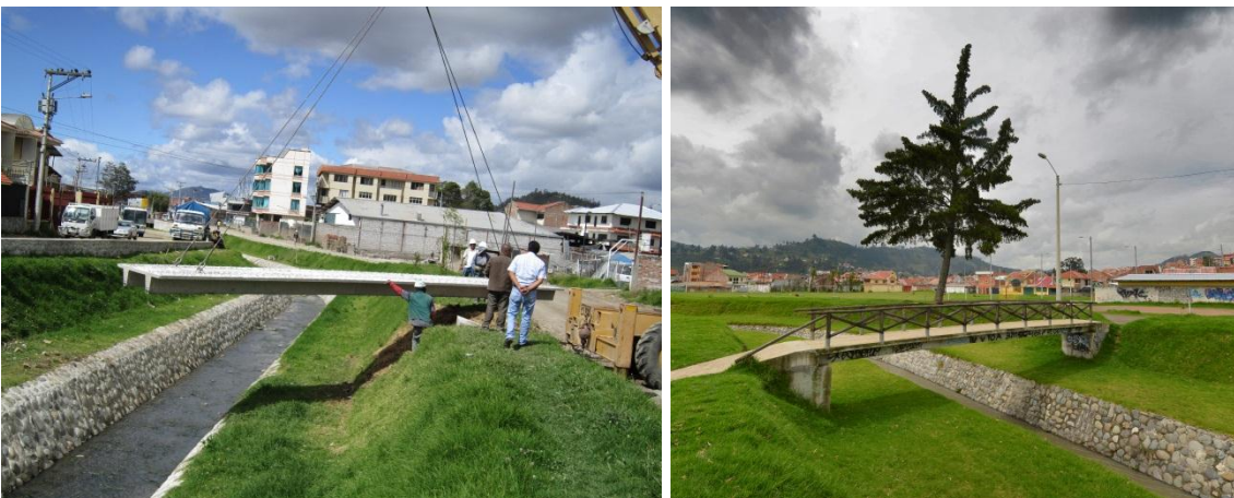
Foto 54 Puente Peatonal, Quebrada del Salado.
