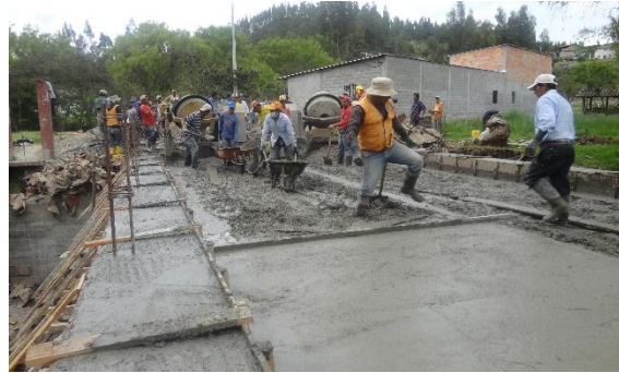
Foto 11 Puente sobre el río Sidcay Conformación de la losa, hormigonado in situ
