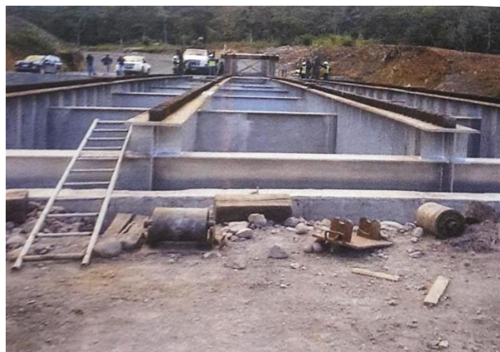
Foto 72 Vigas descendidas hasta el estribo correspondiente, Fuente: Arq. Patricio Aguirre
