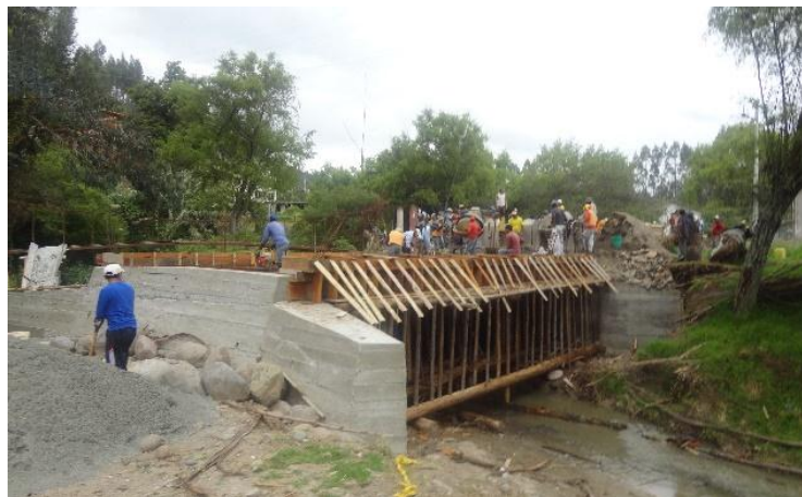
Foto 10 Puente sobre el río Sidcay Encofrado artesanal para losa de superestructura
