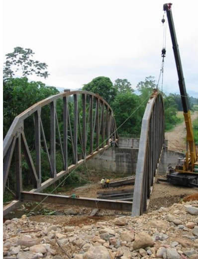
Foto 73 Montaje de estructuras con grúa Fuente: http://www.esacero.com
