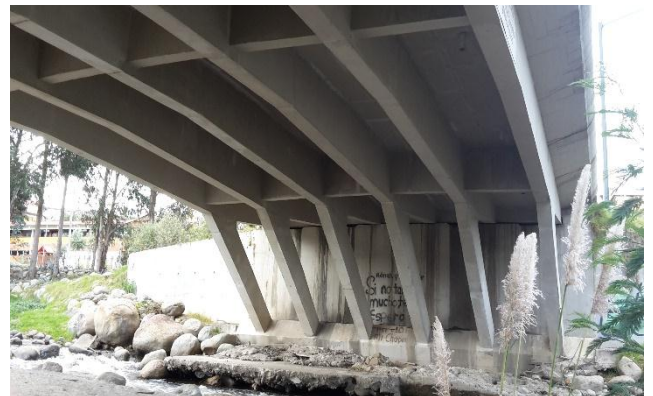
Foto 17 Puente Misticata hormigón armado muros de escolleras y soportes inclinados.
