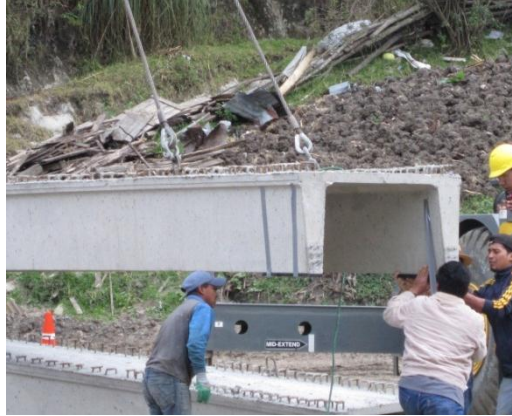
Foto 33. Losas Doble T. Puente de la cárcel Fuente: C-RFV construcciones
