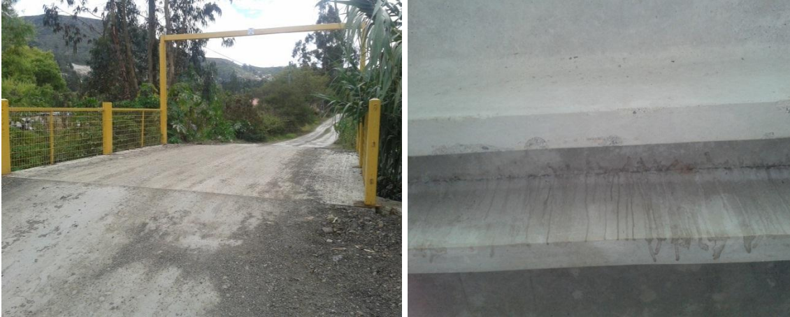
Foto 53 Puente de retorno, autopista Cuenca – Azogues, Estación de Servicio Primax.
