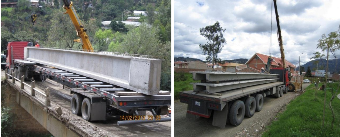
Foto 44 Plataforma de transporte eje tándem para el transporte de elemento prefabricados Fuente: C-RFV construcciones
