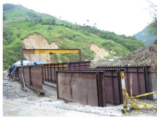
Foto 66 Armado de vigas con ayuda del pórtico estructural Puente el Salado Grande. Carretera Guamote-El Atillo-9 de Octubre- Macas Fuente: www.patricioaguirre.com
