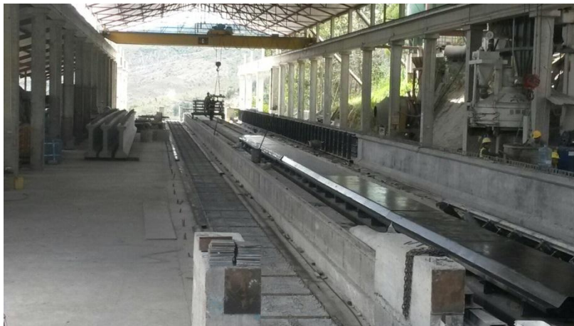
Foto 40 Infraestructura Fábrica C-RFV construcciones
