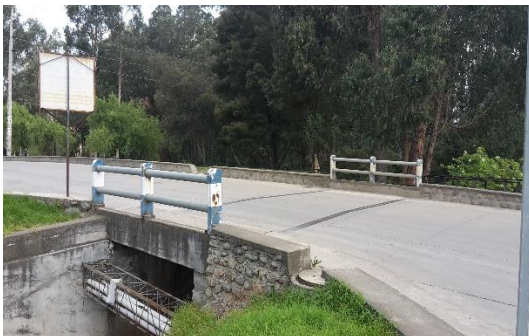
Foto 26 Diseño de puente de losa el puente se funde directamente sobre los estribos de hormigón armado, ubicado en la quebrada de Sacay en el paseo 3 de Noviembre zona Urbana, Ing. Jorge Amaya.
