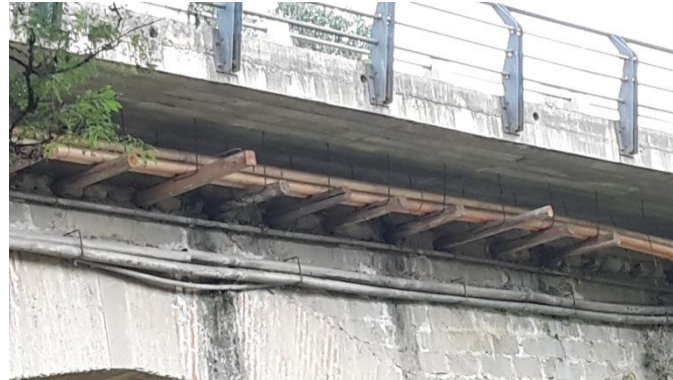
Foto 5 Puente sobre la quebrada Sidcay, puente de mampostería de piedra, Reconstrucción de tablero con hormigón Armado.
