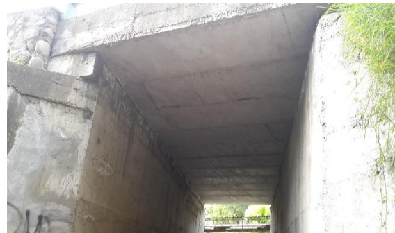
Foto 26 Diseño de puente de losa el puente se funde directamente sobre los estribos de hormigón armado, ubicado en la quebrada de Sacay en el paseo 3 de Noviembre zona Urbana, Ing. Jorge Amaya.
