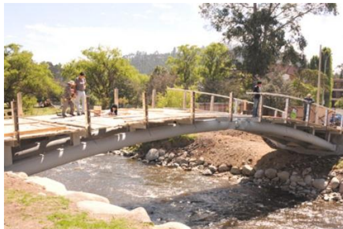
Foto 83 Colocado del tablero en pasarela peatonal sobre el Río Tomebamba Fuente: www.elmercurio.com.ec
