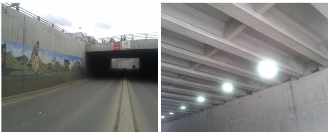
Foto 52 Paso a desnivel, Avenida de las Américas, Redondel avenida Ordóñez Lazo.
