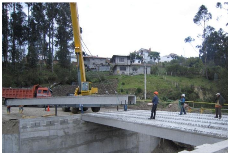
Foto 47 Plataforma de transporte eje tándem para el transporte de elemento prefabricados Fuente: C-RFV construcciones
