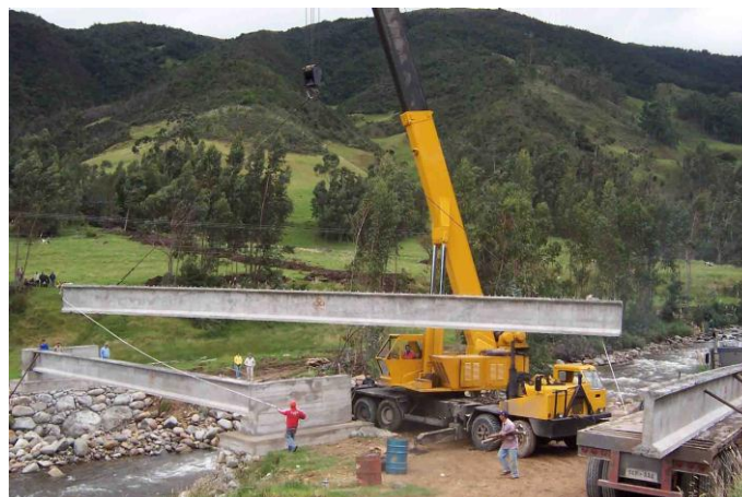
Foto 50 Puente de Acceso a la comunidad de Soldados
