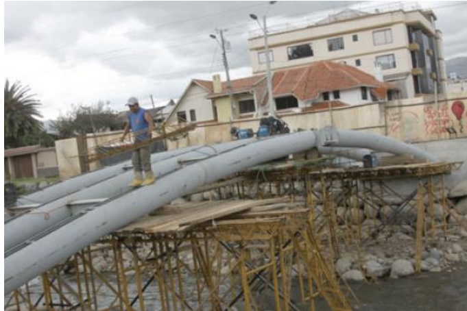
Foto 82 Armado de pasarela peatonal sobre el Río Tomebamba Fuente: www.elmercurio.com.ec
