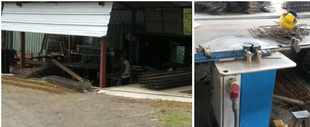
Foto 41 Área de doblado de acero de refuerzo Fábrica C-RFV construcciones
