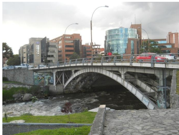
Foto 74 Puente sector Todos Santos, puente en arco de acero estructural ASTM A588 Fuente: www.am-sur.com
