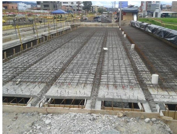
Foto 51 Mejoramiento del Puente Yanuncay para el proyecto tranvía con sistemas de prefabricados.
