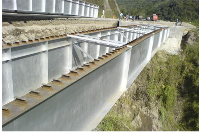
Foto 55 Superestructuras en viga Fuente: Arq. Patricio Aguirre
