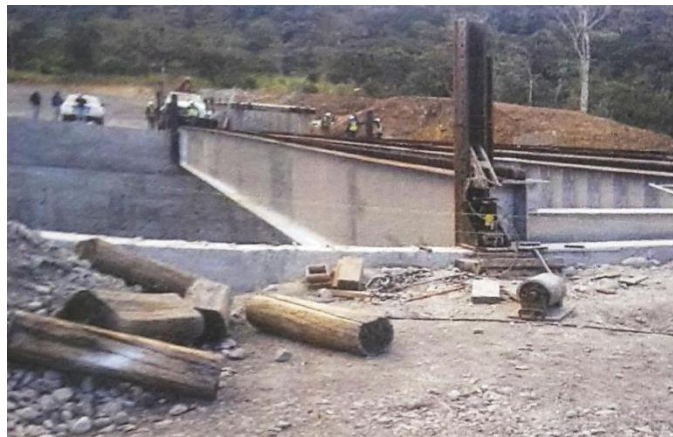
Foto 71 Descenso de la viga hasta apoyarla sobre los estribos Fuente: Arq. Patricio Aguirre
