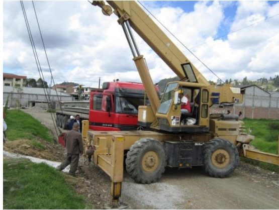
Foto 45 Grúa hidráulica utilizada para el montaje de los elementos prefabricados Fuente: C-RFV construcciones
