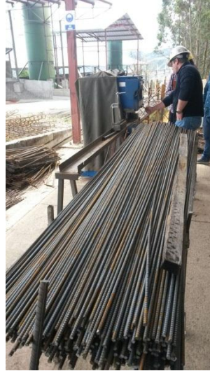
Foto 37 Acero de refuerzo Fábrica C-RFV construcciones
