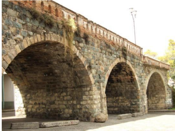
Foto 3 Puente Roto, estructura de mampostería de piedra y balaustrada de ladrillo Fuente: www.tripadvisor.com
