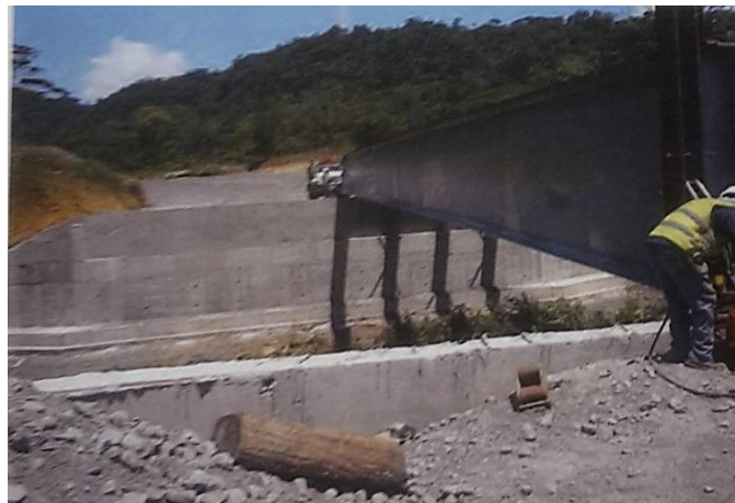
Foto 68 Primeras vigas colocadas Fuente: Arq. Patricio Aguirre
