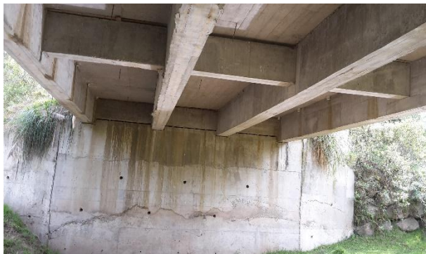
Foto 15 Puente hormigón armado de vigas recta Pichacay sobre río Quingeo, 18 metros de luz y 8 m de ancho
