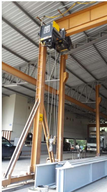
Foto 65 tecla de 5 toneladas para manipulación de dovelas
