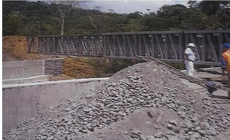
Foto 67 Lanzamiento del contrapeso o nariz de montaje Fuente: Arq. Patricio Aguirre
