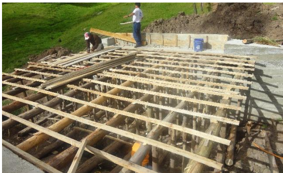
Foto 7 Construcción del puente sobre el río Chapar Encofrados artesanales y fundición in situ para la losa de la superestructura.
