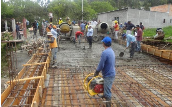
Foto 11 Puente sobre el río Sidcay Conformación de la losa, hormigonado in situ
