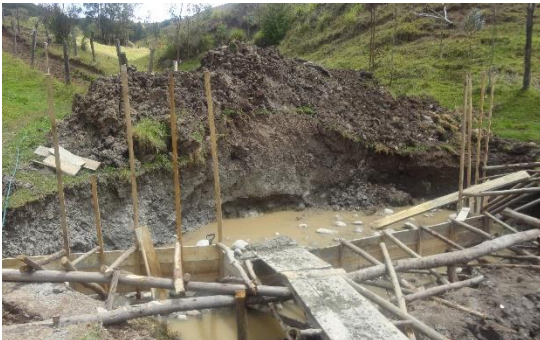
Foto 6 Construcción del puente sobre el río Chapar Encofrados artesanales para la conformación de los estribos y muros.
