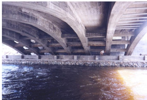
Foto 28 Disposición de vigas longitudinales y transversales
