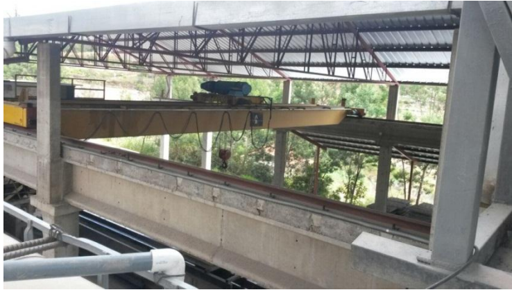
Foto 42 Puente Grúa, manipulación de elementos Fábrica C-RFV construcciones
