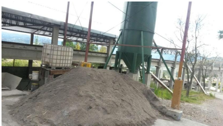
Foto 43 Tolvas de dosificación de material Fábrica C-RFV construcciones
