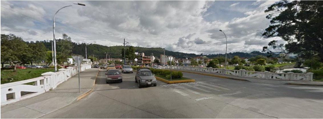
Foto 27 Puente "El Paraíso" Puente en arco, similar al de Misicata.
