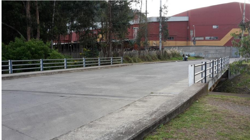
Foto 79 Puente mixto, Sector Mall del Río
