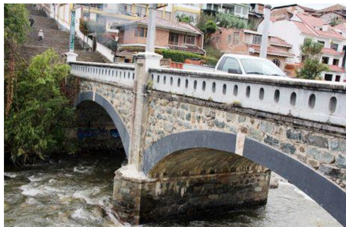
Foto 4 Puente Mariano Moreno, Puente con arcos de piedra y mortero de Cal Fuente: www.eltiempo.com.ec
