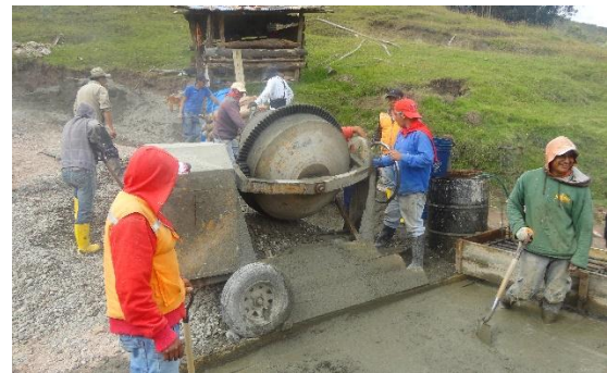
Foto 7 Construcción del puente sobre el río Chapar Encofrados artesanales y fundición in situ para la losa de la superestructura.
