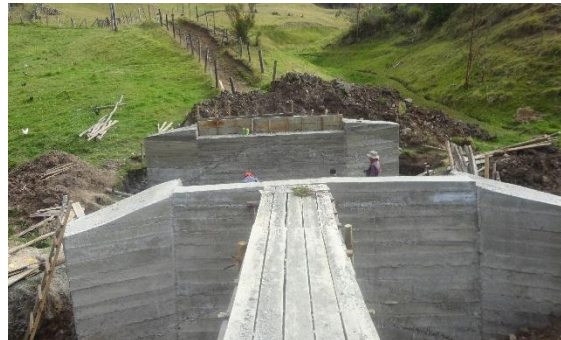
Foto 6 Construcción del puente sobre el río Chapar Encofrados artesanales para la conformación de los estribos y muros.
