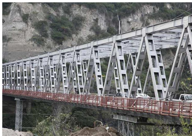
Foto 56 Superestructuras en Celosía Fuente: google.com.ec
