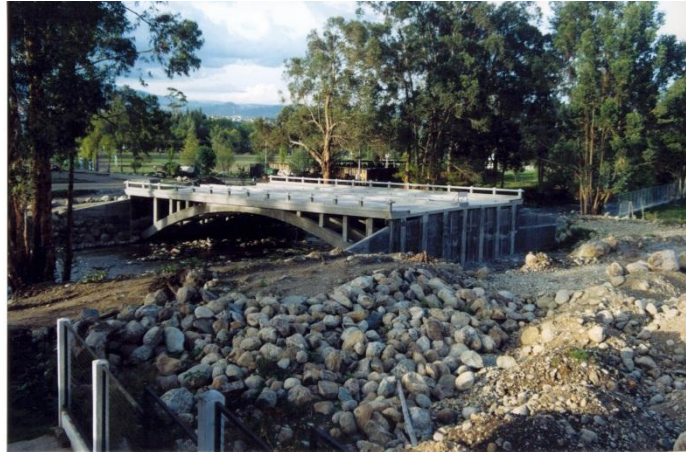
Foto 29 Puente de Chaguarchimbana sobre el río Yanucay Fuente: GAD Cuenca
