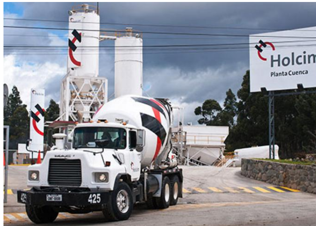
Foto 19 Fábrica de Hormigón premezclado Empresa Holcim.
