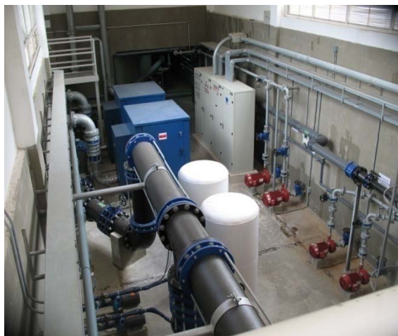
Fig. 1-35. Bombas para agua de arrastre de cloro
