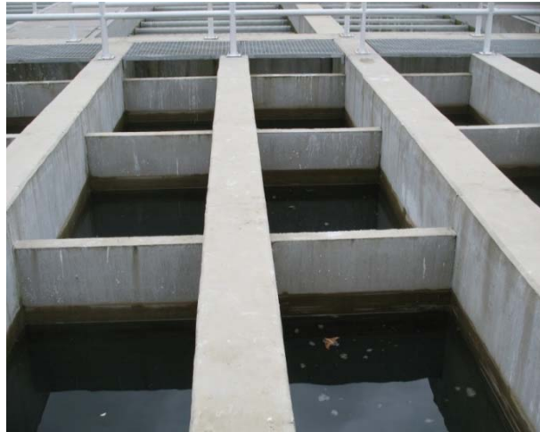
Fig. 1-21. Floculadores hidráulicos
