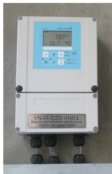
Fig. 1-10. Display del medidor de pH en el ingreso de agua cruda
