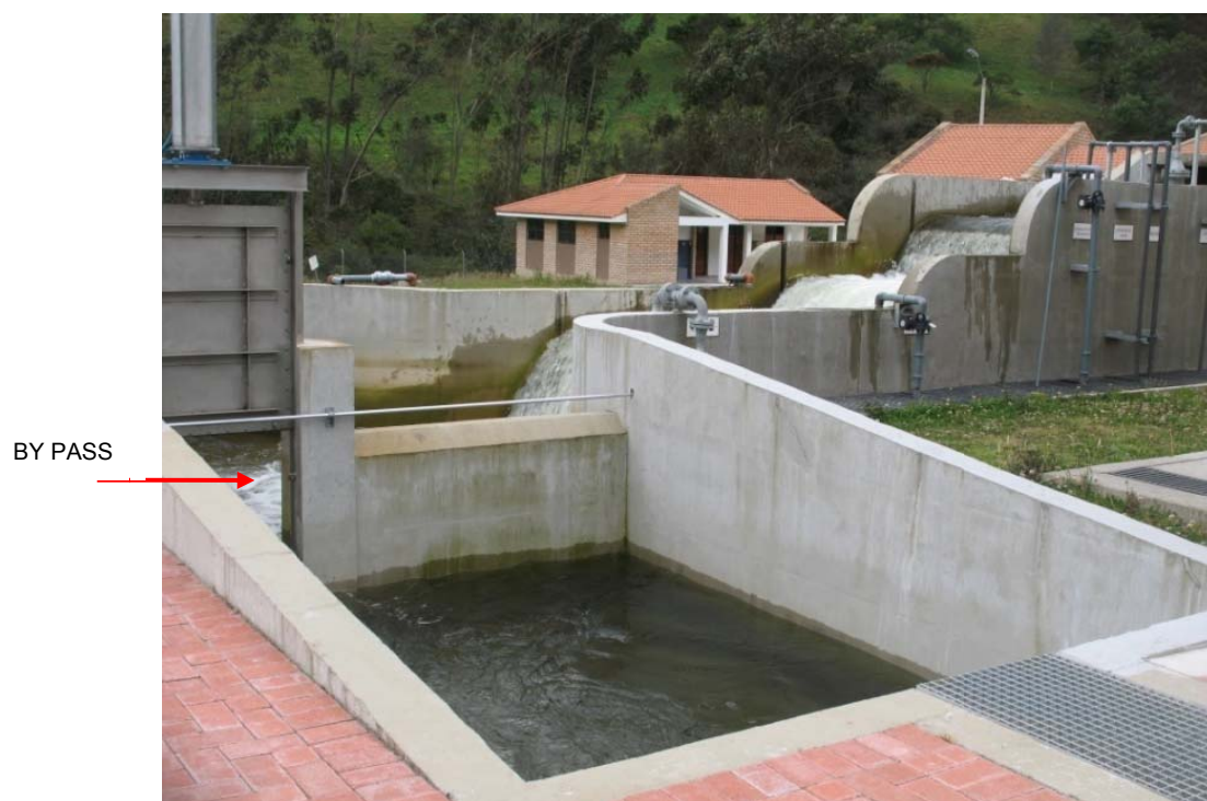
Fig.1- 12. Mezcla rápida y by pass.
