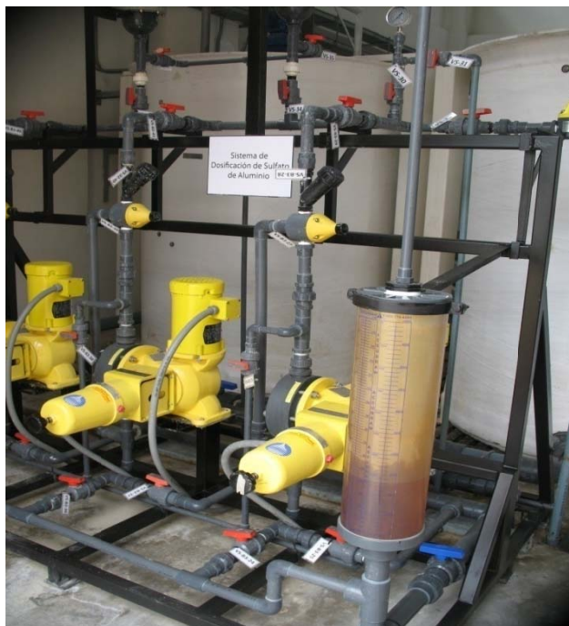
Fig. 1-17. Sistema de dosificación de Sulfato de Aluminio FUENTE: AUTOR
