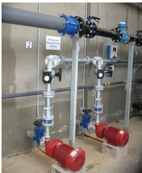
Fig. 1-36. Bombas para agua de arrastre de cloro
