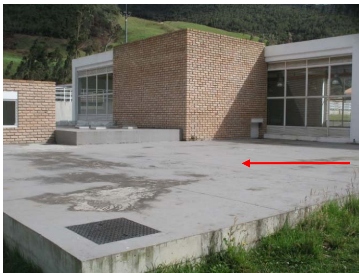
Fig. 1-26. Cámara de contacto de cloro
