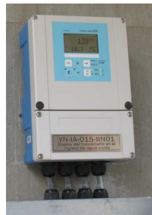
Fig. 1-8. Display del Turbidímetro en el ingreso de agua cruda
