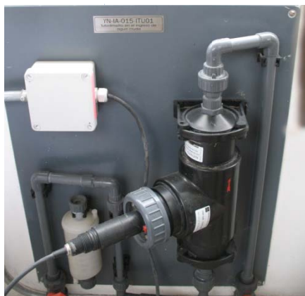
Fig. 1-7. Turbidímetro en el ingreso de agua cruda
