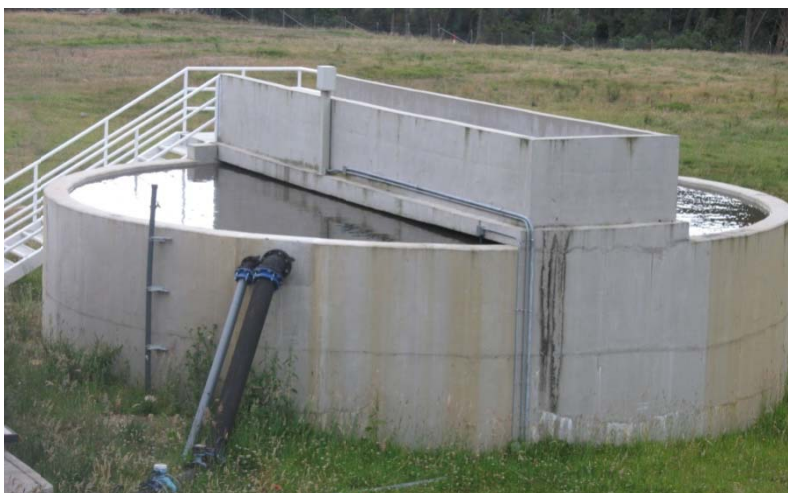
Fig. 1-32. Espesador de Fangos.
