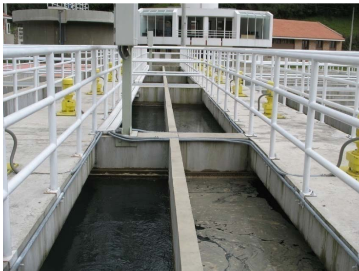
Fig. 1-20. Floculadores mecánicos
