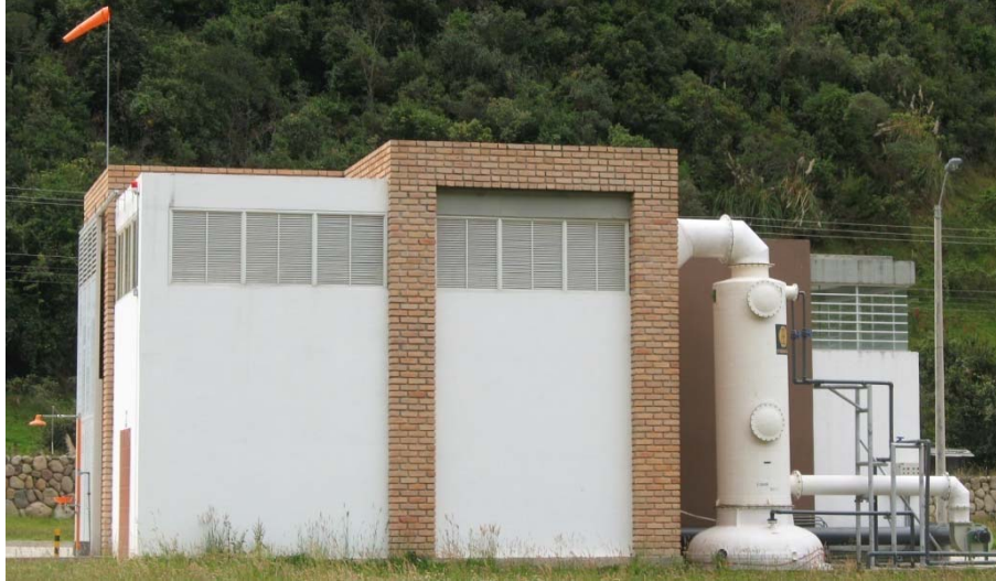
Fig. 1-27. Edificio de cloración FUENTE: AUTOR
