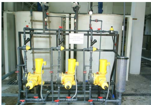
Gráfico 4-26. Cubas de preparación del Sulfato de Aluminio.
