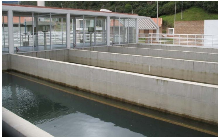
Fig. 1-24. Filtros con lecho de arena
