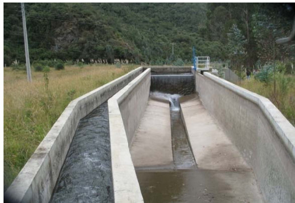
Fig.1-3. Desarenador
