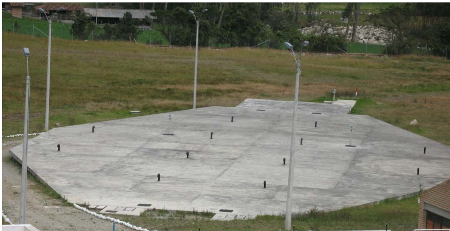
Fig. 1-30. Depósito de agua tratada
