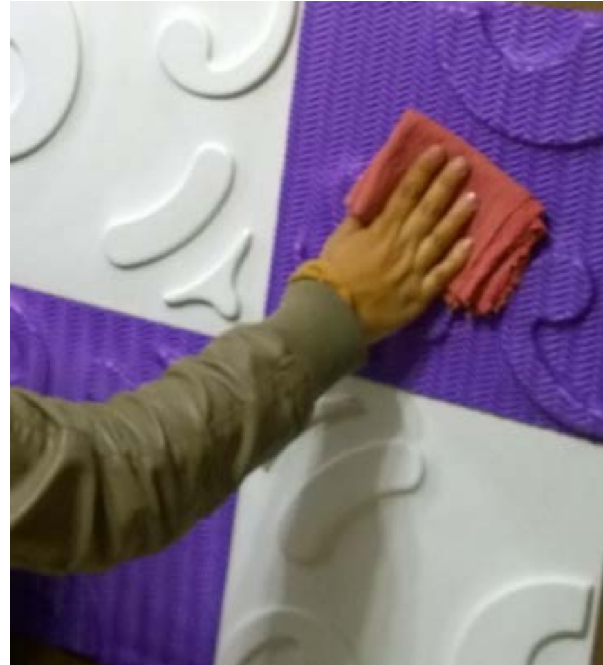
Imagen 4.61 Limpiar la superficie
