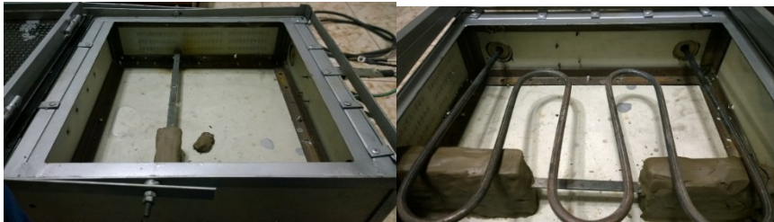
Imagen 3.31 Armado de estructura de la caja de niquelinas
