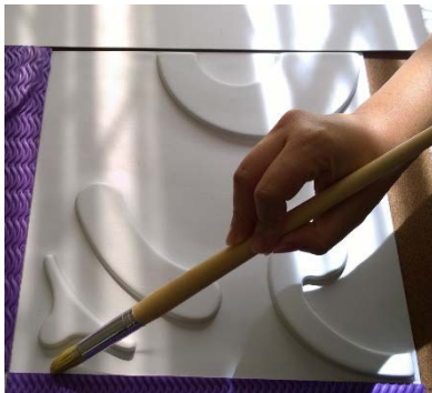
Imagen 4.59 Limpieza de juntas
