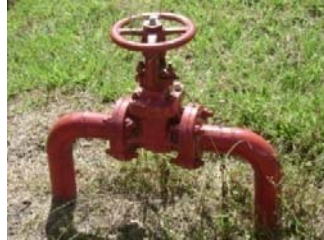
Figura 1.57 Válvula Tipo compuerta. Figura 1.58 Rociadores.
