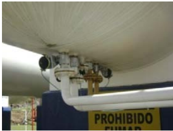
Figura 1.31. Válvulas Neumáticas.
