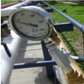
Figura 1.34. Manómetro Burdon.
