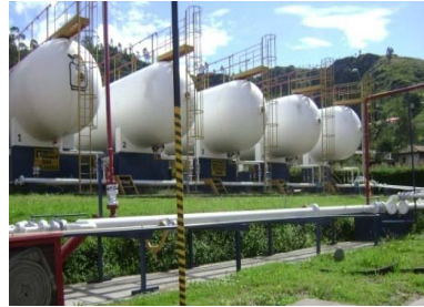
Figura 1.6. Tanques de Almacenamiento de GLP.
