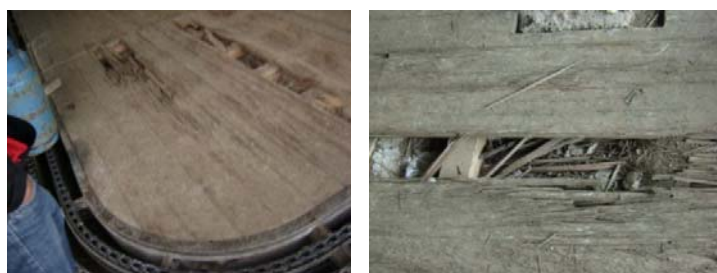
Figuras 3.8 y 3.9. Suelo de la plataforma de carga y descarga.
