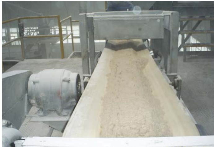
Foto N°3 Banda b2, Planta de Molienda de Itaipisos Fuente: Los Autores
