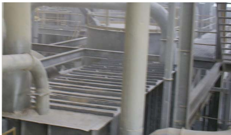
Foto N°5 Ductos para toma de polvos, Planta de Molienda de Itaipisos Fuente: Los Autores.
