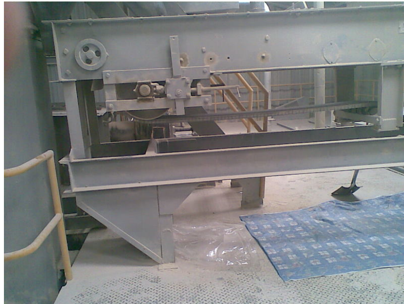
FOTO 7: Colocación del material para muestreo
