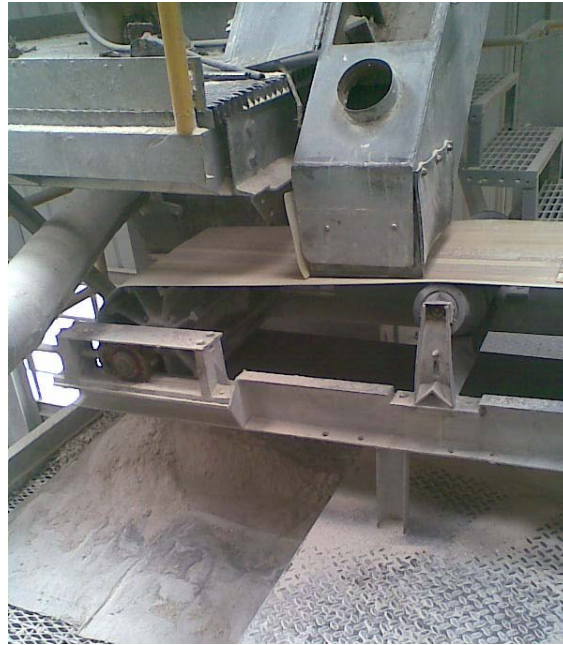
Foto N°4 Banda b2, Planta de Molienda de Itaipisos Fuente: Los Autores
