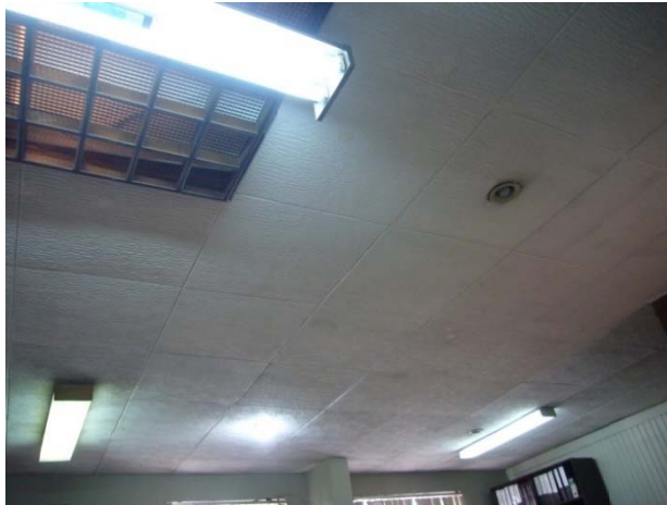
FIG N° 17: No utilización de focos ahorradores
