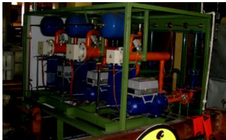
Figura 60. Montaje de variadores de velocidad para compresores
