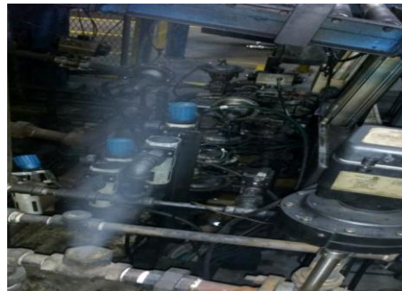
Fotografías Fugas y Falta de aislamiento
