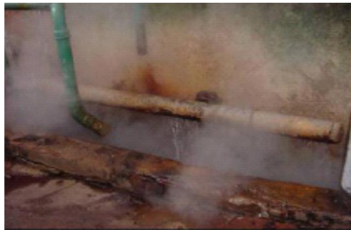
Fotografías Fugas y Falta de aislamiento
