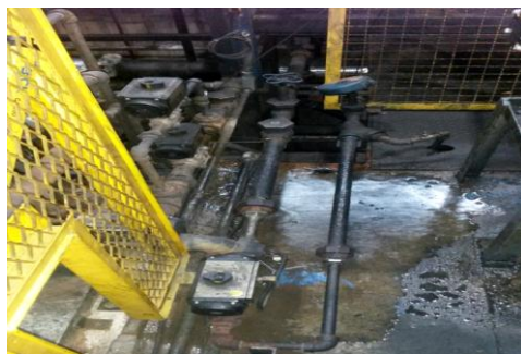
Fotografías Fugas y Falta de aislamiento
