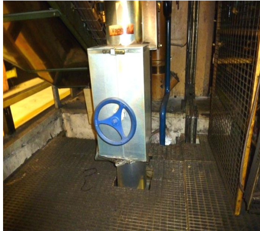
Figura 58. Asilamiento de válvula Fuente: Autor
