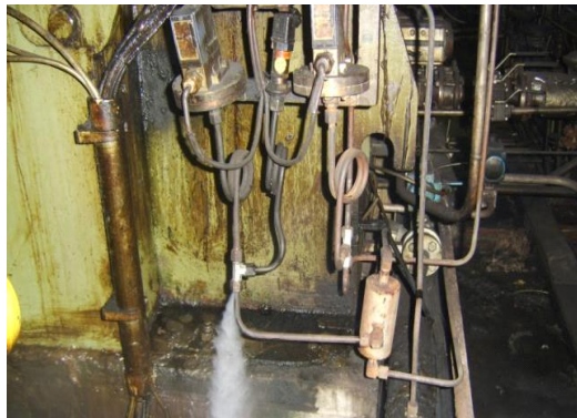
Fotografías Fugas y Falta de aislamiento
