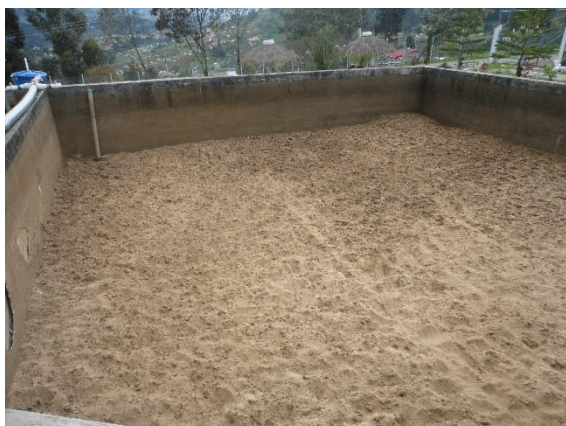
Figura 1-13. Lecho Filtrante (Arena) FUENTE: AUTOR
