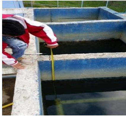
Fig. 6-1. Determinación de la velocidad de filtración
