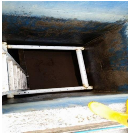
FIG. 6-6 Filtro Vacío para la Determinación de la velocidad de lavado de un filtro
