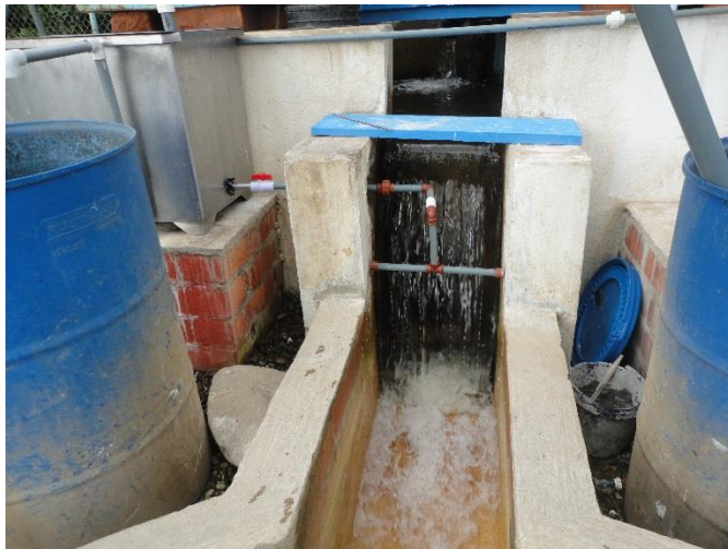
Figura 1-5. Resalto Hidráulico FUENTE: AUTOR
