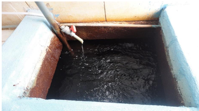
Figura 1-15. Dosificación por goteo FUENTE: AUTOR
