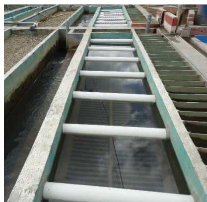
Figura 1-9. Decantadores de Flujo Ascendente FUENTE: AUTOR
