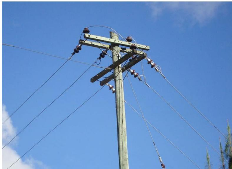
Figura 3-5 Poste de madera para redes de distribución eléctrica [55]
