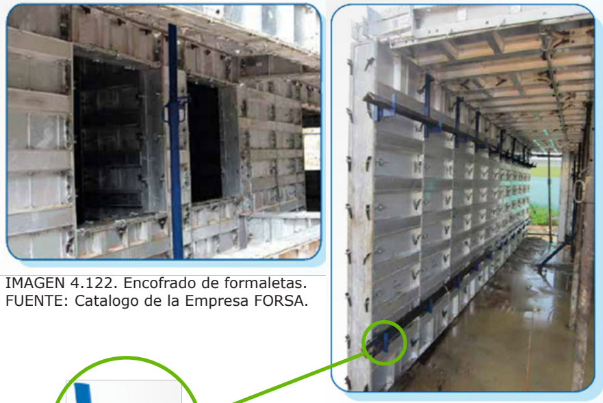
IMAGEN 4.123. Tensores colocados. FUENTE: Catalogo de la Empresa FORSA.
