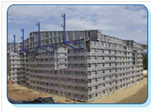
IMAGEN 4.124. Alineadores colocados. FUENTE: Catalogo de la Empresa FORSA.
