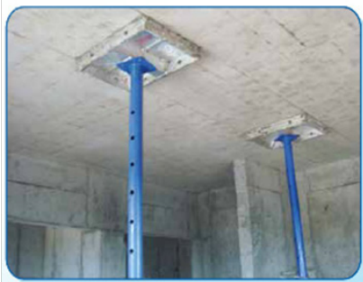
IMAGEN 4.103. Formaleta losa puntual. FUENTE: Catalogo de la Empresa FORSA.
