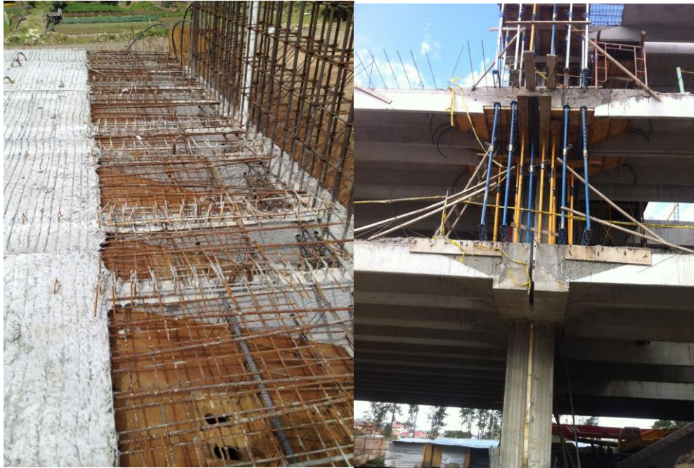
Ilustración 2: Hormigonado in situ de conexión Muro-Losa TT. Proyecto Universidad de Cuenca, Balzay
