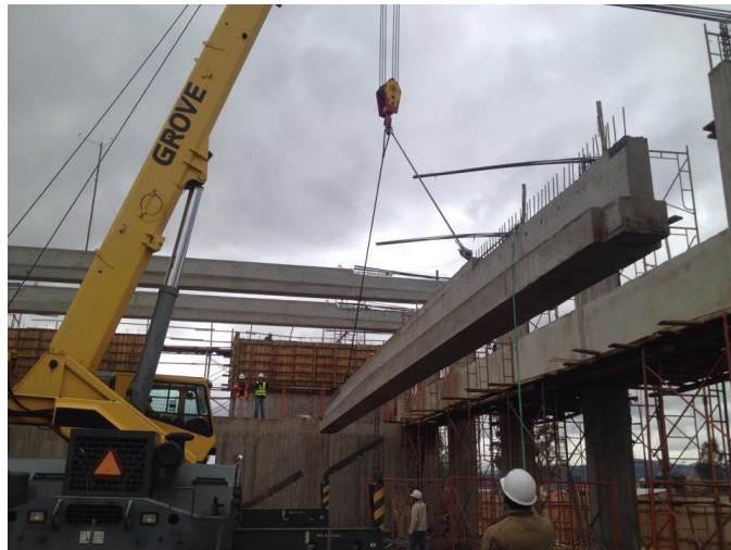
Ilustración 3: Izaje de una viga prefabricada-pretensada. Proyecto Universidad de Cuenca, Balzay.
