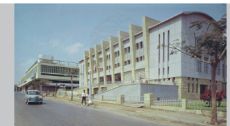
Museo de Historia Natural - Luanda - África - 1956 / s.XX Esqueleto interno Material: hormigón armado
