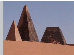
Pirámides Nubias de Meroe - Egipto - África - 315 a 295 / s.IV-III Arquitectura adintelada Materiales: piedra y tierra
