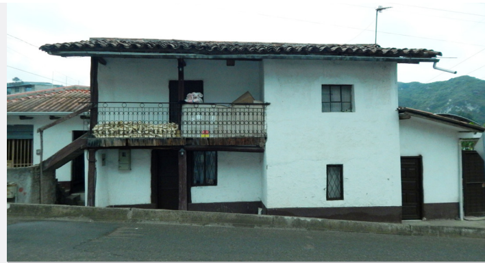
PORTAL LATERAL EN PLANTA BAJA Y ALTA /AZUAY
