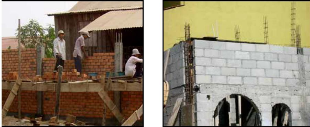
Figura 4.7. Construcción del pórtico relleno (imagen izquierda) y Construcción de la mampostería confinada (imagen derecha)
