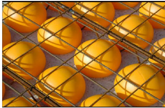
Figura 2.18. Esferas de polietileno de alta densidad. [5]
