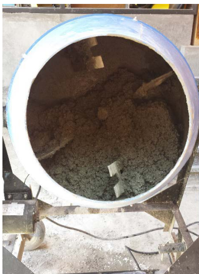
Figura 10. Mezclado del hormigón
