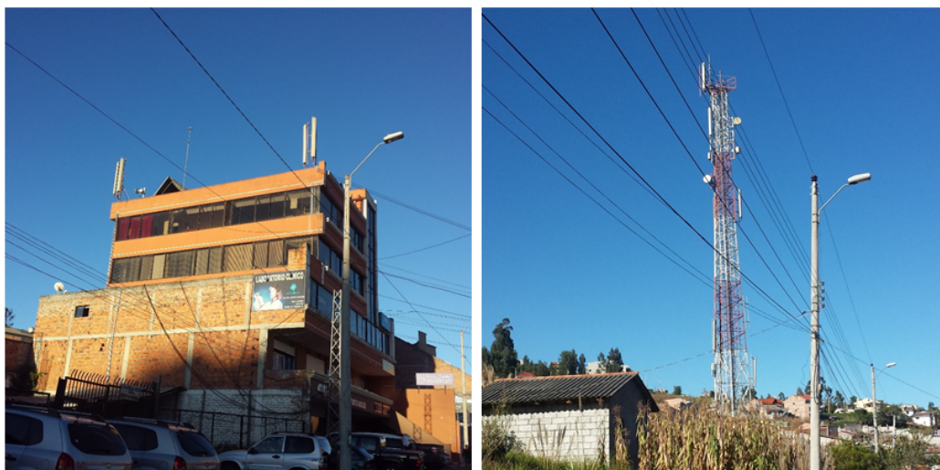
Figura 7.4: Antenas de Zona representativa 3 (Edificios).
