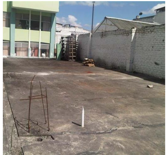
Fig. 7-1 Vista Noreste de área a implementar el Centro de Datos.
