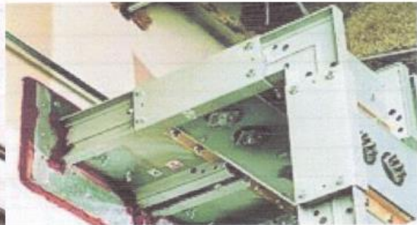
Sistema Modular pasa muros contra fuego con resina epóxica de retardo y almohadillas intumescentes
