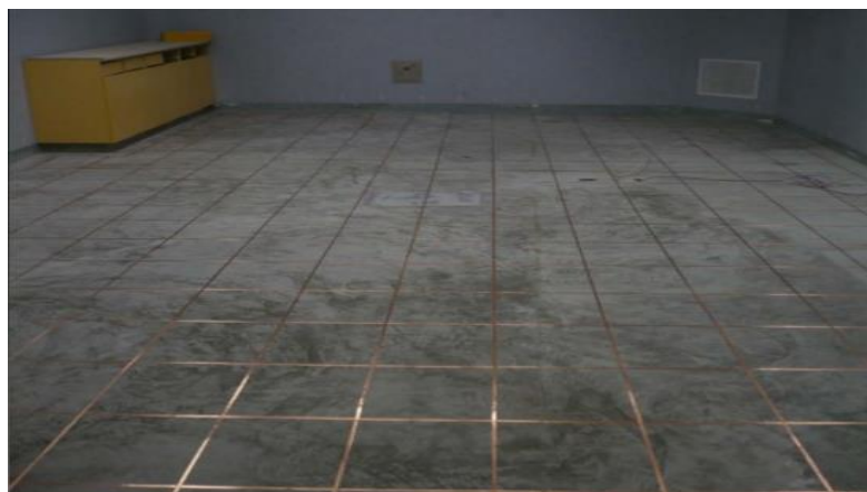
Fig. 7-5 Malla de Alta frecuencia
