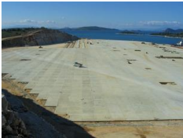
Figura 2.15 Pavimento de la terminal de contenedores en el puerto de Astakos. (Bekaert, 2003)
