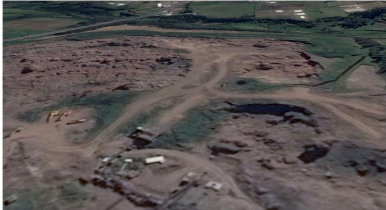
Figura 4.1 Cantera CONSTRUARENAS CIA. LTDA. Fuente: Google Earth.
