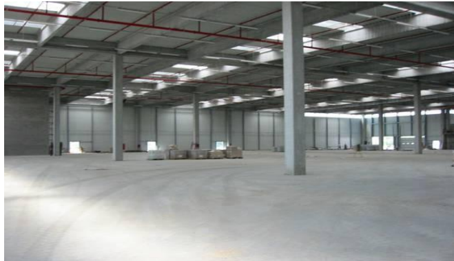
Figura 2.14 Pavimento "Fercam" sin Juntas de retracción. (Bekaert, 2000).
