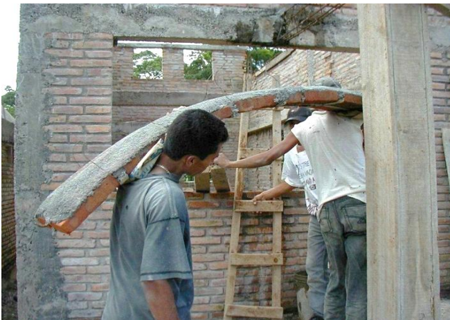
Foto 5. Hiladas prefabricadas de ladrillo. Nicaragua.
