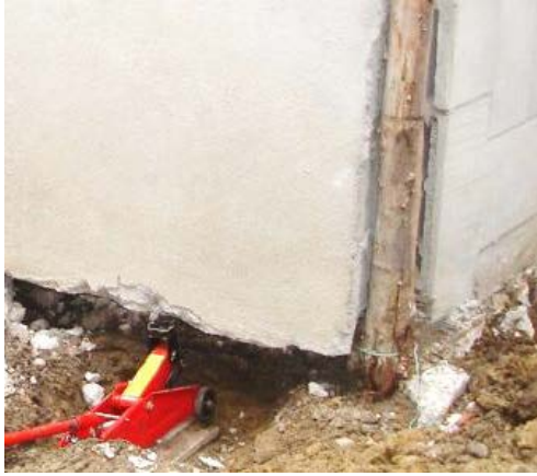
Foto. 40. Fuerza vertical aplicada con gata hidráulica.
