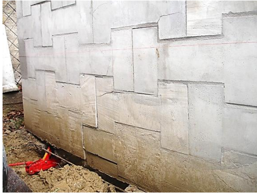
Foto. 43. Fuerza vertical aplicada con gata hidráulica.
