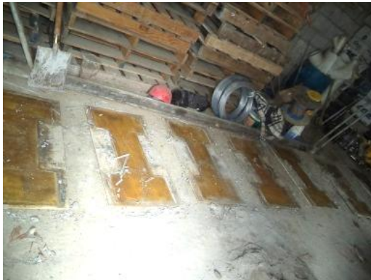
Foto. 31. Bases de moldes para elemento tipo 3.
