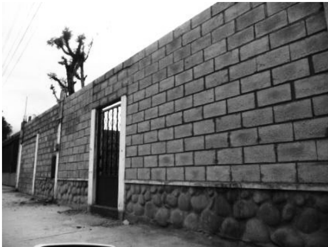
Foto 4. Cerramiento de bloque de pómez.
