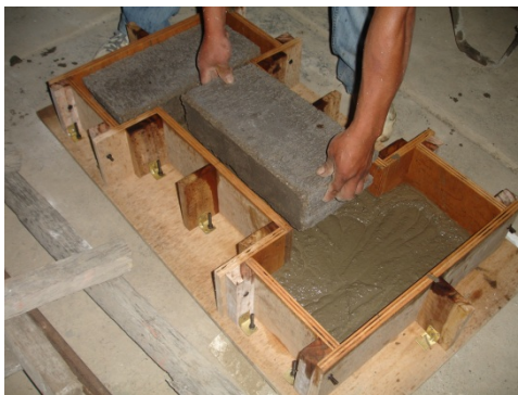
Foto.18. Colocación de los bloques de pómez.
