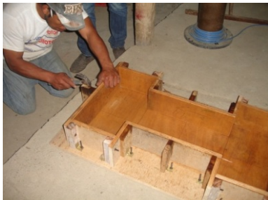
Foto.14. Armado de piezas laterales.
