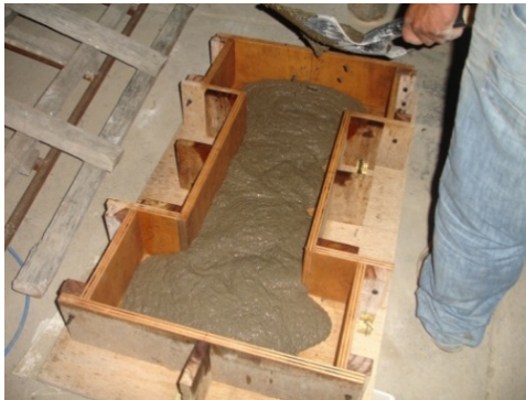
Foto.17. Primera capa de recubrimiento.
