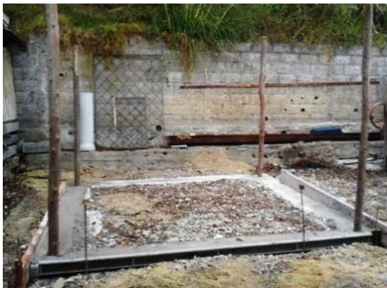
Foto 33. Estructura de apoyo.
