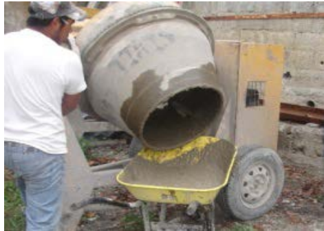
Foto.16. Elaboración del mortero
