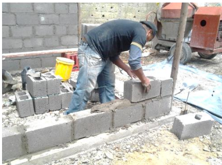
Foto. 39. Construcción de mampostería tradicional.
