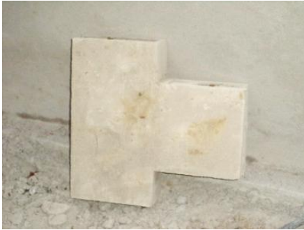
Foto. 37. Elemento modular cortado con amoladora.
