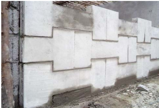
Foto. 35. Mampostería propuesta en proceso de construcción.
