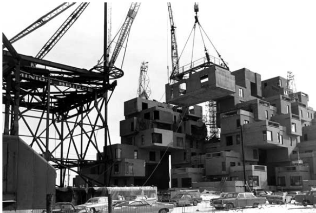
Foto 9. Complejo de Vivienda Experimental para la Expo Mundial de 1967, Montreal - Canadá. Moshe Safdie, arquitecto.
