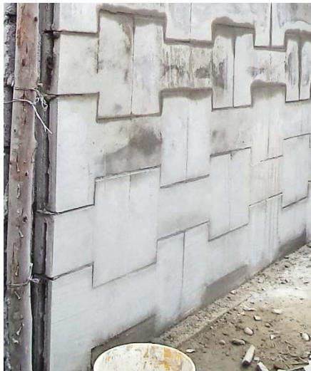
Foto. 38. Mampostería propuesta construida.
