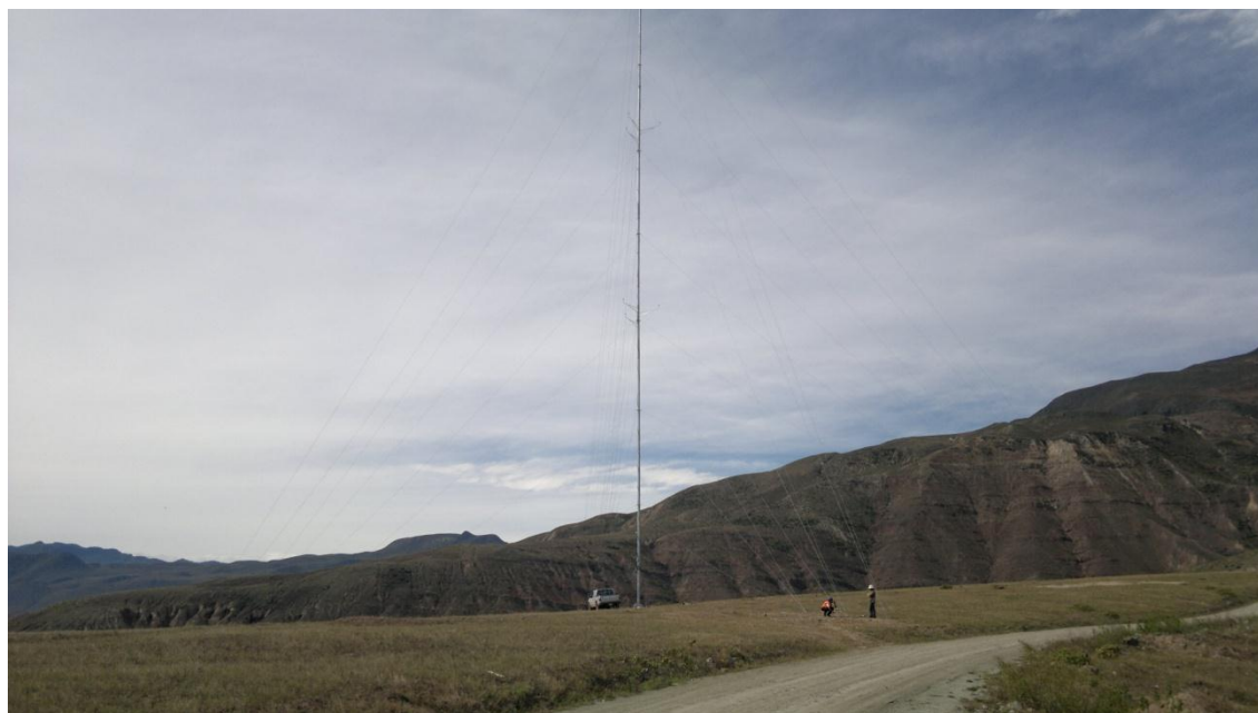
Figura 3.5 Estación meteorológica YULUC 80 instalada en el sitio del PEMH
