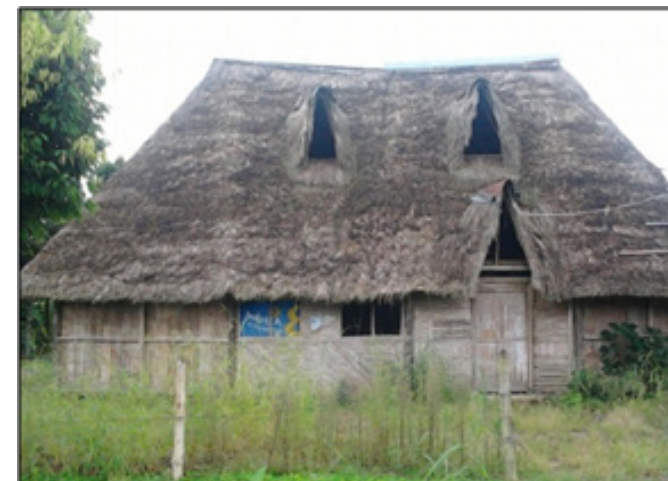
Ilustración 9. Casa tradicional en la vía Fuente: Julio Pesántez (2014)
