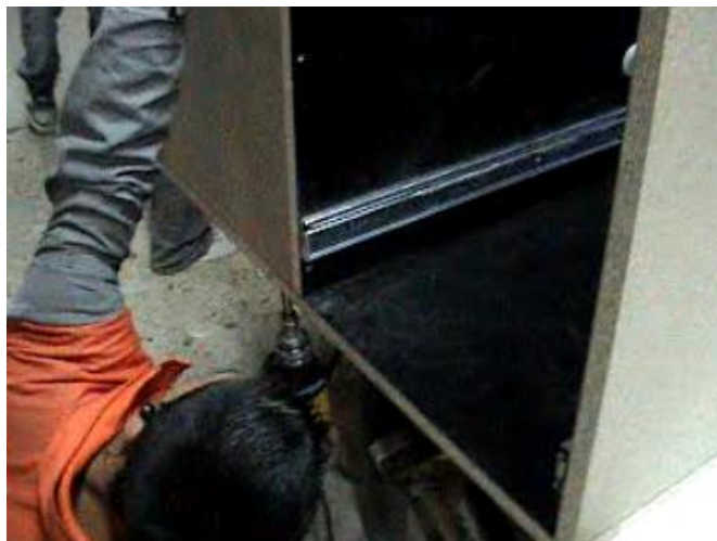
Figura 14. Colocación de niveladores (Autor)
