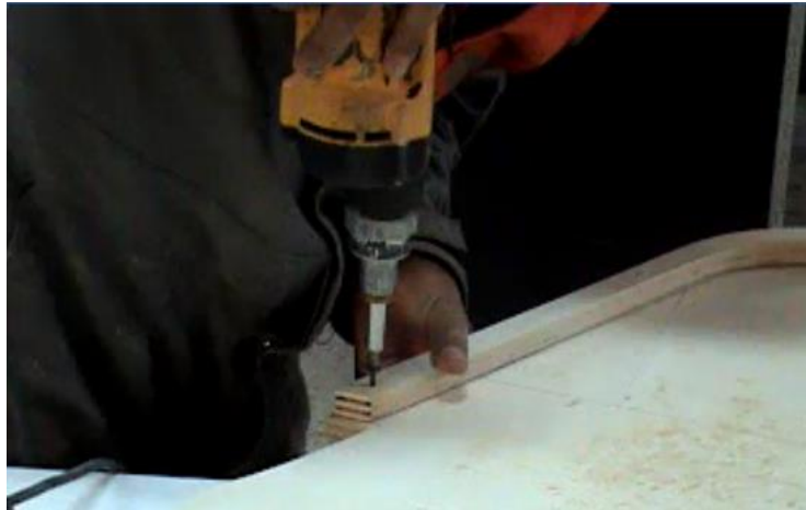
Figura 12. Perforación de tablero (Autor)
