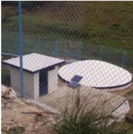
Imagen 7 a. Tanque de reserva de Agua Potable de Parccoloma.
