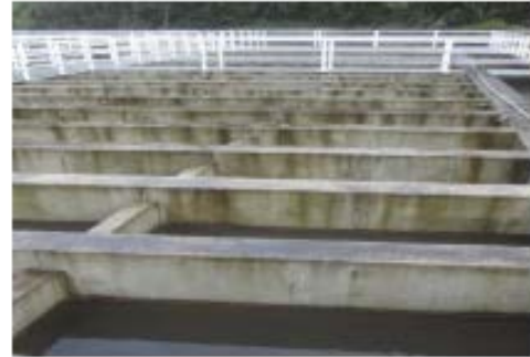
Imagen 4.b. Floculadores Hidráulico.
