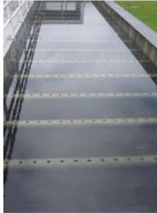
Imagen 5. Sedimentador. (Planta Sustag)
