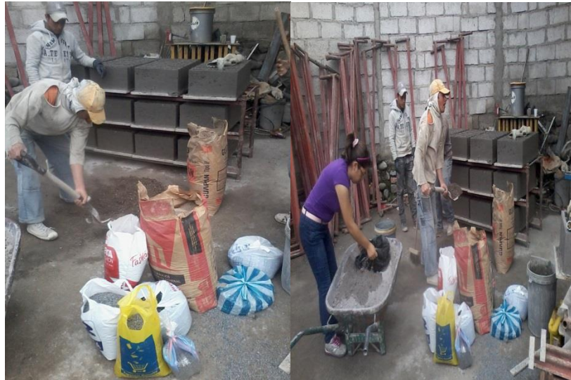
Ilustración 1.- Dosificación de la Mezcla Fotografiado por: Las Autoras Lugar: Bloquera INDUBLOCK (Av. De los Cerezos s/n y Av. Ordóñez Lasso)
