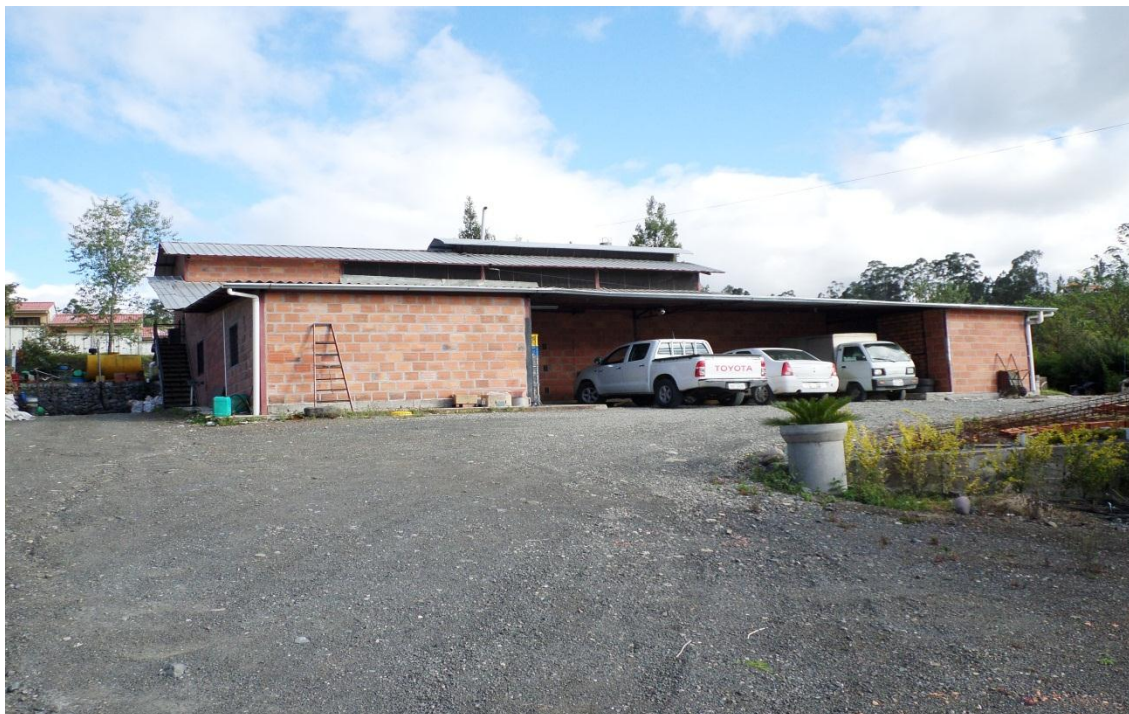
Figura 2.A, Fotografía de los exteriores de la fábrica. Tomada por el autor. Fuente: Frituritas de Don Miguel.
