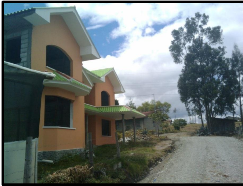
Foto No. 60: Construcción de casas cerca de las nuevas vías. 2013.
